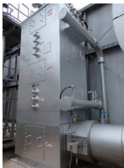
第2図 排ガス温水ボイラ Fig. 2 Exhaust gas waste heat recovery boiler
