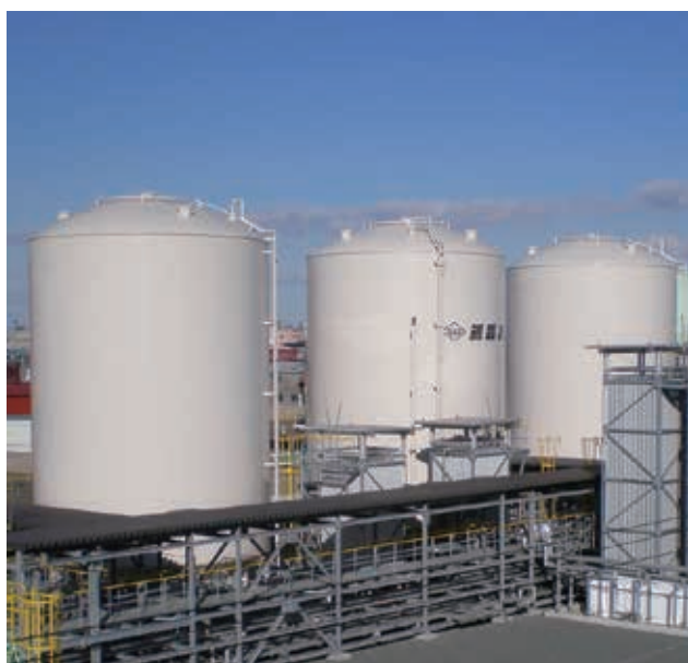
釧路ガス株式会社仲浜工場向け 600 m 3 LNG タンク × 3 基
