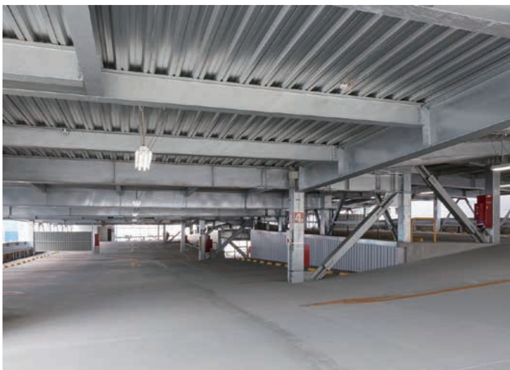
省エネルギー対策を施した自走式駐車場内部
