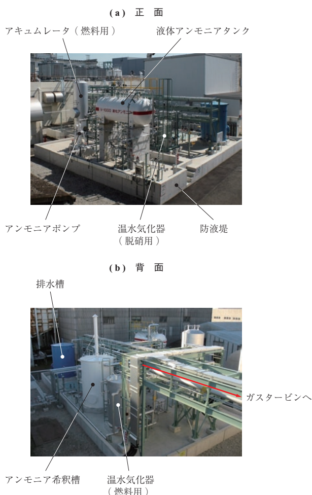
第 5 図 アンモニア供給装置 Fig. 5 Apparatus of ammonia supply unit
