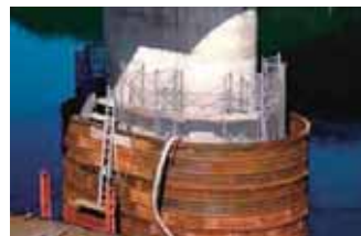
④排水後、仮締切完了
