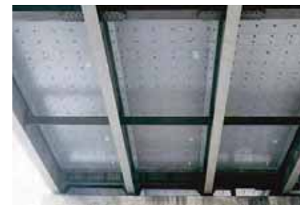
鋼板接着補強
