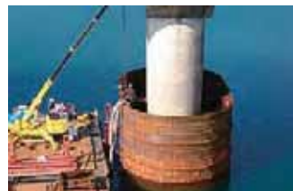
④排水後、仮締切完了
