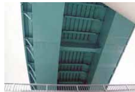
リブ付鋼板接着補強
