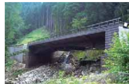
ごろごろ橋(奈良県) 構造形式:PRCエクストラードズポータルラーメン橋 橋長:52.0m 竣工年:2004年
