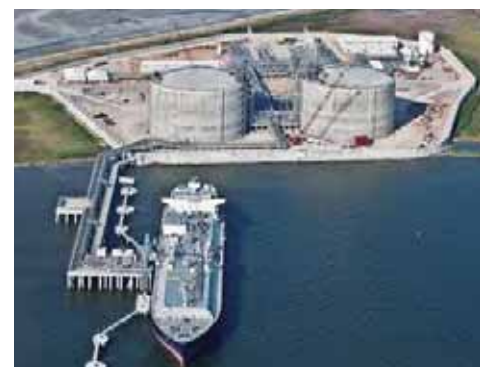
ガルフLNGクリーンエネルギーPJ(アメリカ) 構造形式:地上式PC LNGタンク 容量:16万m 3 /基 竣工年:2012年
