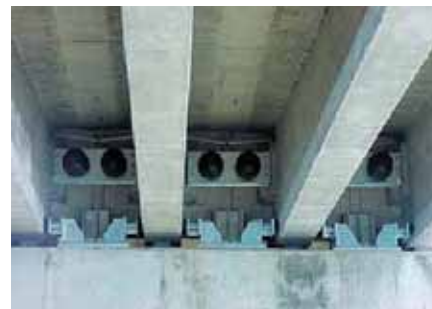
コンクリート橋
