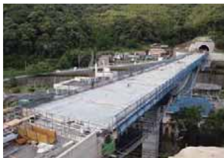
上戸町高架橋(長崎県) 構造形式:鋼3径間連続非合成箱桁橋 橋長:148.0m 鋼重:344t 竣工年:2011年
