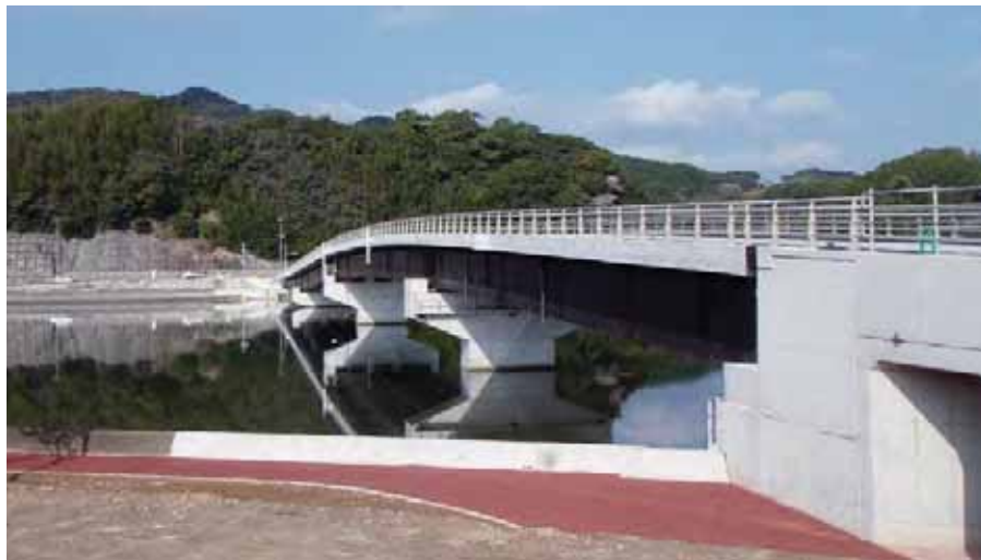
瀬戸中央橋(長崎県) 構造形式:鋼4径間連続非合成箱桁橋 橋長:228.0m 鋼重:901t 竣工年:2009年
