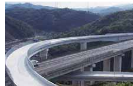
尾道ジャンクションCランプ橋(広島県) 構造形式:鋼3径間連続非合成箱桁橋+PC3径間連続ラーメン箱桁橋 橋長:376.0m 竣工年:2007年
