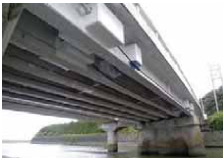
PC桁補強
