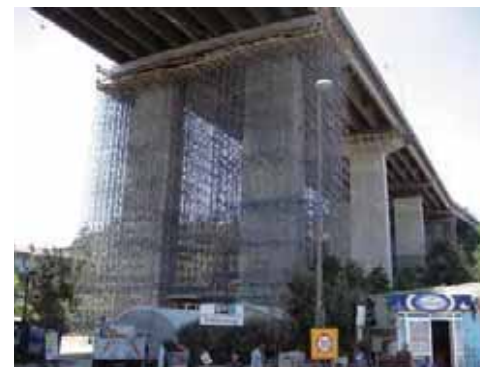
オルタキョイ高架橋耐震補強(トルコ) 構造形式:コンクリート門型ラーメン橋脚 橋脚高:16.7~39.6m 竣工年:2009年
