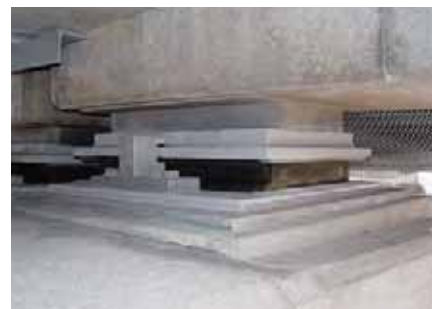
コンクリート橋
