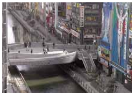
戎橋(大阪市) 構造形式:単純鋼床版版桁橋 橋長:26.0m 鋼重:188t 竣工年:2008年
