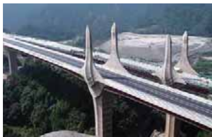
近江大橋(滋賀県) 構造形式:PC5径間連続エクストラードズ波型鋼板ウェブ橋 橋長:555.0m 竣工年:2007年
