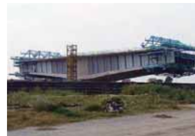
台中高快速道路C709A(エンジニアリング)(台湾) 構造形式:4径間連続PC波形鋼板ウェブ3室箱桁橋 橋長:476m 竣工年:2011年
