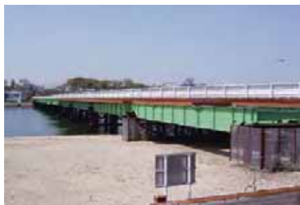
芦屋橋仮橋(福岡県) 構造形式:鋼鈑桁 橋長:252.0m 竣工年:2011年
