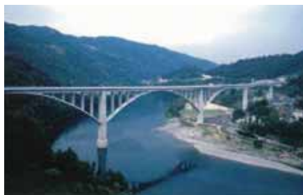
池田へそっ湖大橋(徳島県)【田中賞受賞】 構造形式:PC5径間連続バランسدアーチ橋 橋長:705.0m 竣工年:1999年
