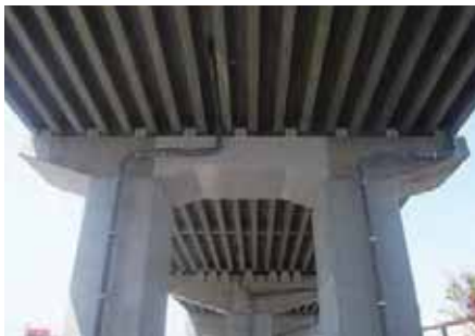
柱:RC巻立て 梁:鋼板巻立て
