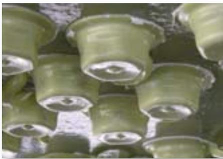
6 連結タイプでキャップが浮き上がる場合は、充填材不足が原因の場合があります。再度充填材を加えて取り付けして下さい。
