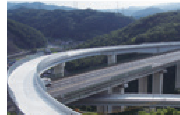
尾道ジャンクションランプ橋 (広島県) 構造形式: 鋼3径間連続非合成箱桁橋+PC3径間連続ラーメン箱桁橋 橋長: 376.0m 竣工年: 2007年
