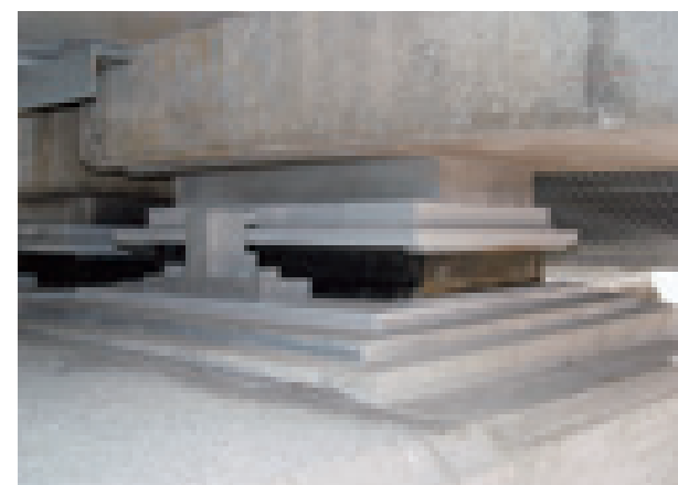
コンクリート橋
