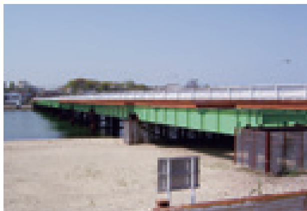
芦屋橋仮橋 (福岡県) 構造形式: 鋼鉸桁 橋長: 252.0m 竣工年: 2011年
