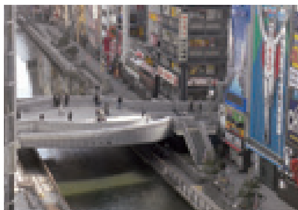
戎橋（大阪市） 構造形式：単純鋼床版板桁橋 橋長：26.0m 鋼重：188t 竣工年：2008年
