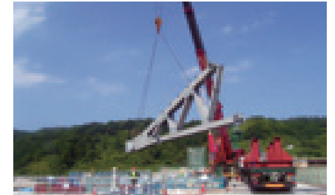
尾原ダム(島根県) 設備名:非常用放流設備(クレストゲート) 形式:鋼製ラジアルゲート 数量:2門 純径間:11.500m 有効高:14.020m 開閉装置形式:油圧シリンダー式 竣工年:2011年
