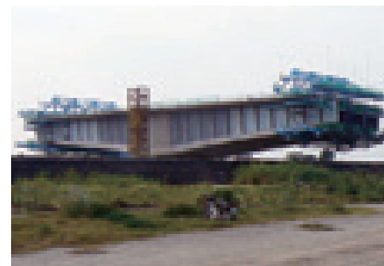
台中高速道路C709A (エンジニアリング) (台湾) 構造形式: 4径間連続PC波形鋼板ウェブ3室箱桁橋 橋長: 476m 竣工年: 2011年
