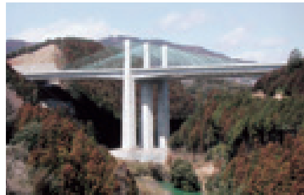
都田川橋 (静岡県) 【田中賞受賞】 構造形式: PC2径間連続エクストラードズ箱桁橋 橋長: 268.0m 竣工年: 2001年
