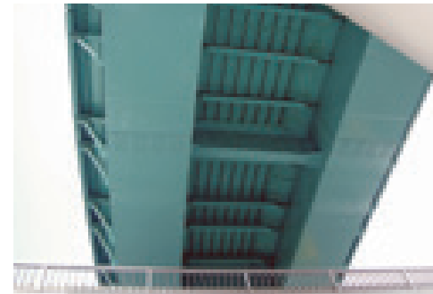
リブ付鋼板接着補強
