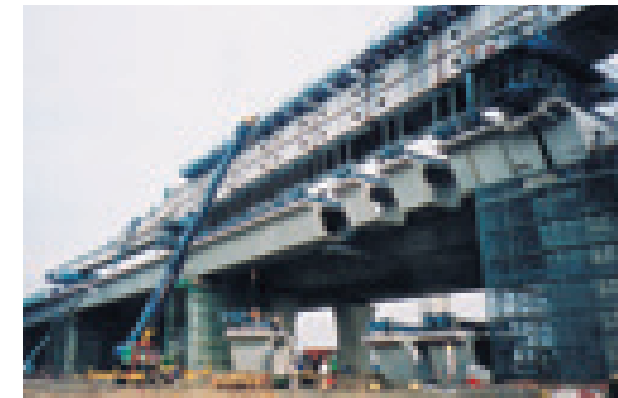
川越高架橋 (三重県) 構造形式: PC(5+3+8+9+4)径間連続箱桁橋 橋長: 1298.0m 竣工年: 2002年
