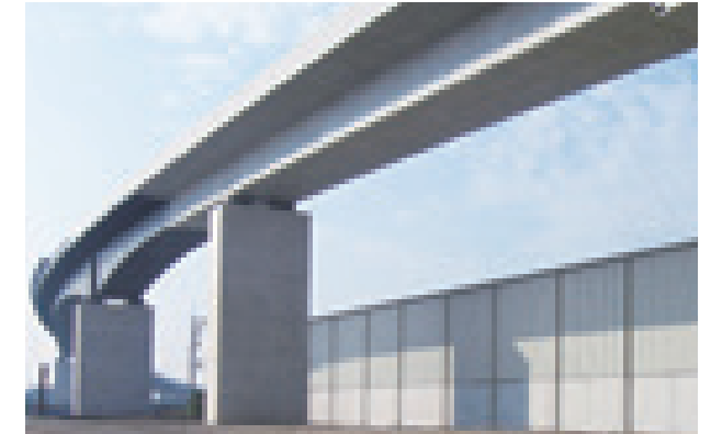
大牟田高架橋 (福岡県) 構造形式: 5径間連続鋼・コンクリート混合箱桁橋 施工長: 354.0m 竣工年: 2007年
