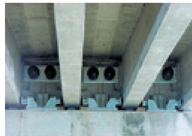
コンクリート橋
