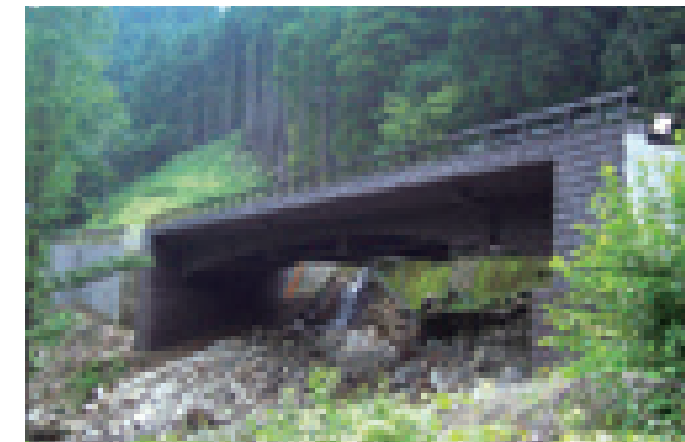
こごろ橋 (奈良県) 構造形式: PRCエクストラードズポータルラーメン橋 橋長: 52.0m 竣工年: 2004年
