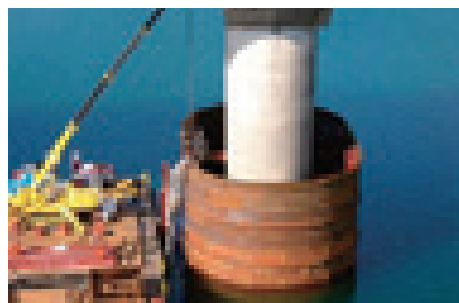
④排水後、仮締切完了
