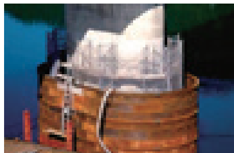
④排水後、仮締切完了
