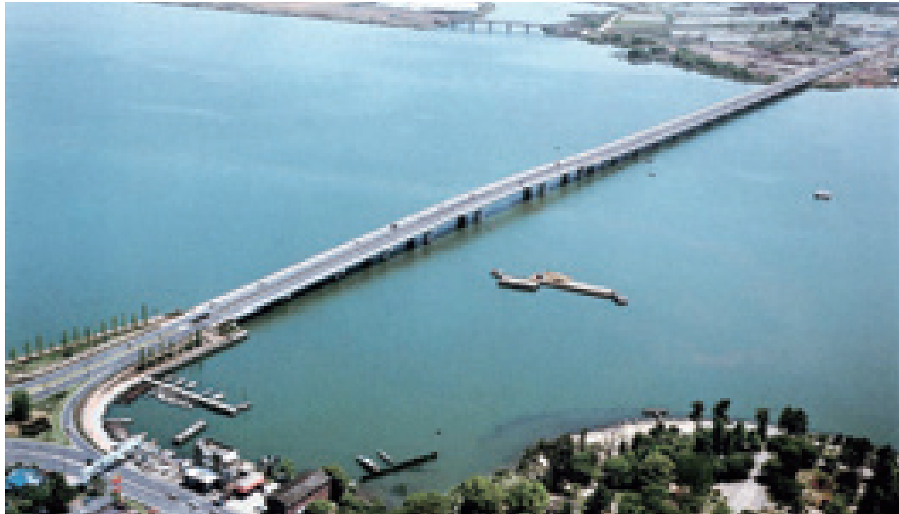
近江大橋 (滋賀県) 構造形式: ポストテンション方式単純T桁橋 橋長: 1290.0m 竣工年: 1974年
