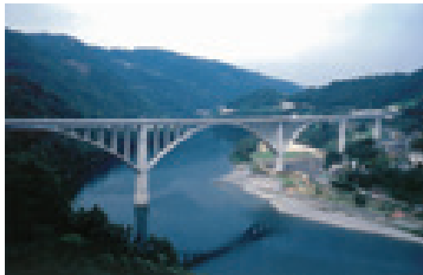
池田へそっ湖大橋 (徳島県) 【田中賞受賞】 構造形式: PC5径間連続バランスドアーチ橋 橋長: 705.0m 竣工年: 1999年
