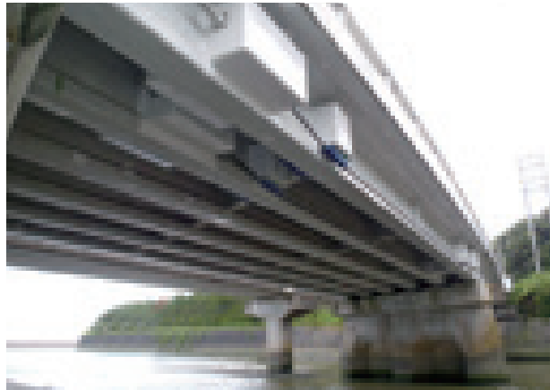
PC桁補強
