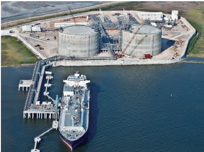
ガルフLNGクリーンエネルギーPJ(アメリカ) 構造形式: 地上式PC LNGタンク 容量: 16万m 3 /基 竣工年: 2012年
