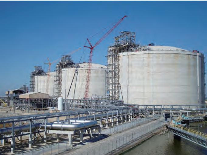
キャメロンLNGタンク(アメリカ) 構造形式: 地上式PC LNGタンク 容量: 16万m 3 /基 竣工年: 2009年
