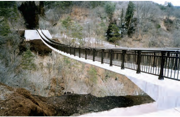
農村公園吊橋 (長野県) 構造形式: PC単純吊床版橋 橋長: 104.5m 竣工年: 1998年
