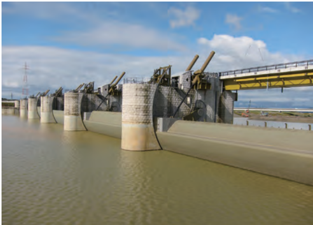
大河津可動堰
