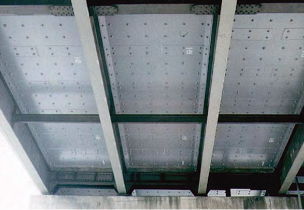
鋼板接着補強
