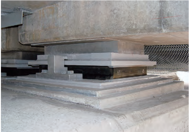
コンクリート橋
