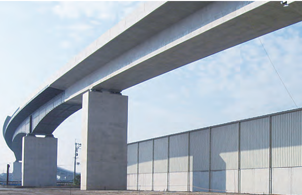
大牟田高架橋 (福岡県) 構造形式: 5径間連続鋼・コンクリート混合箱桁橋 施工長: 354.0m 竣工年: 2007年
