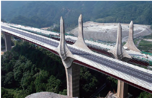
近江大橋 (滋賀県) 構造形式: PC5径間連続エクストラード波型鋼板ウェブ橋 橋長: 555.0m 竣工年: 2007年
