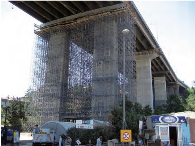
オルタキョイ高架橋耐震補強(トルコ) 構造形式: コンクリート門型ラーメン橋脚 橋脚高: 16.7~39.6m 竣工年: 2009年
