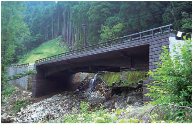
ごろごろ橋 (愛知県) 構造形式: PRCエクストラードポータルラーメン橋 橋長: 52.0m 竣工年: 2004年
