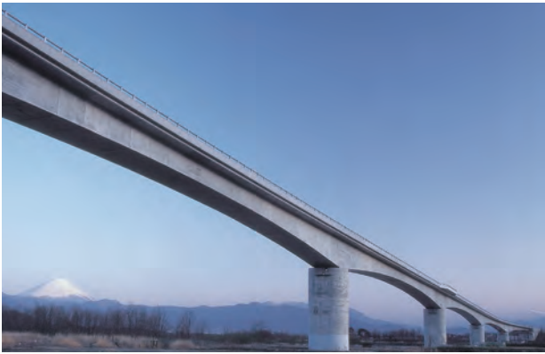
釜無川橋 (山梨県) 構造形式: PC8径間連続ラーメン箱桁橋 橋長: 753.0m 竣工年: 2001年
