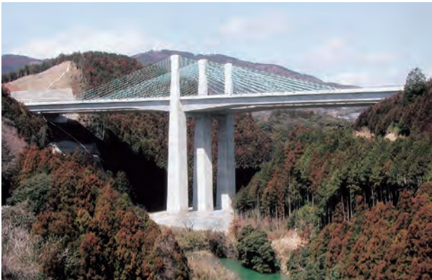
都田川橋 (静岡県) 【田中賞受賞】 構造形式: PC2径間連続エクストラード波型鋼板ウェブ橋 橋長: 268.0m 竣工年: 2001年
