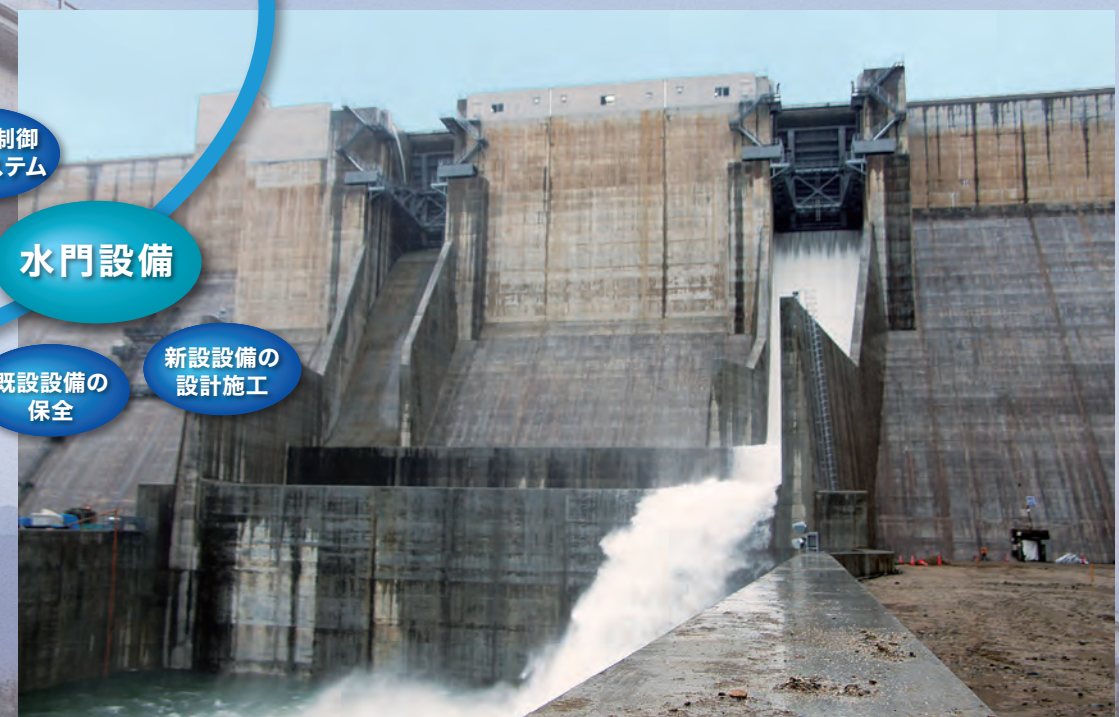
尾原ダム(非常用放流設備<グレストゲート>)
