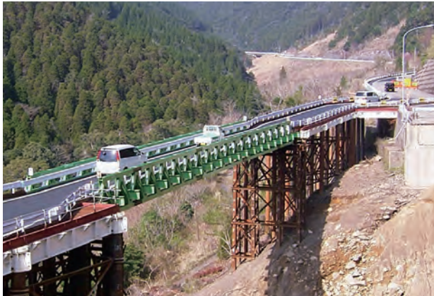
日南災害復旧仮橋(宮崎県) 構造形式: 鋼下路式トラス 橋長: 40.0m 竣工年: 2008年
