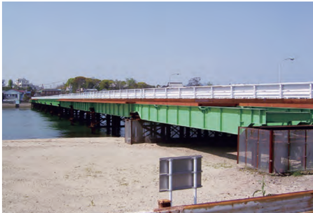
芦屋橋仮橋(福岡県) 構造形式: 鋼鉸桁 橋長: 252.0m 竣工年: 2011年
