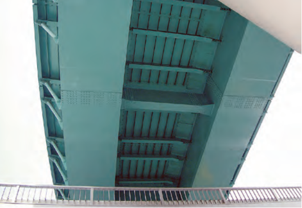
リブ付鋼板接着補強
