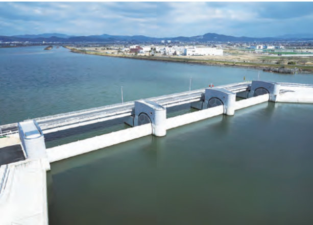
百間川河口水門
