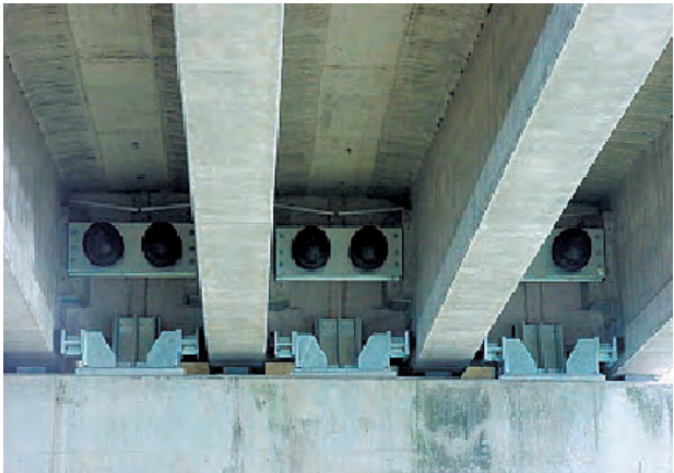
コンクリート橋
