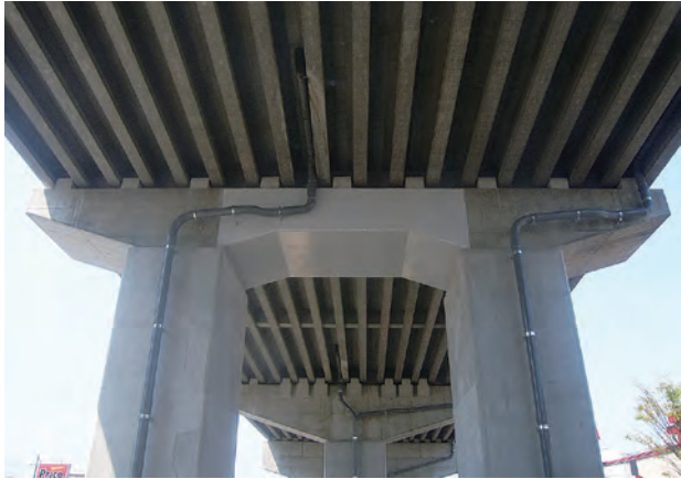
柱:RC巻立て 梁:鋼板巻立て
