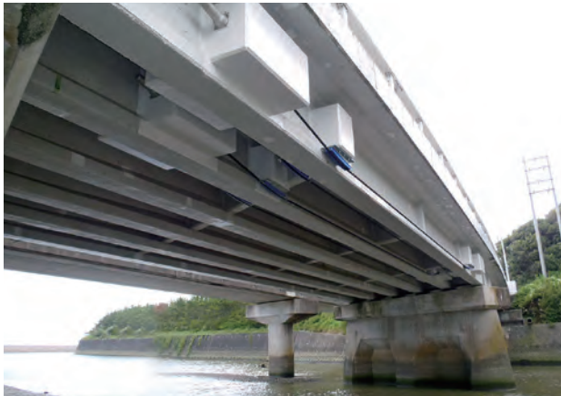
PC桁補強
