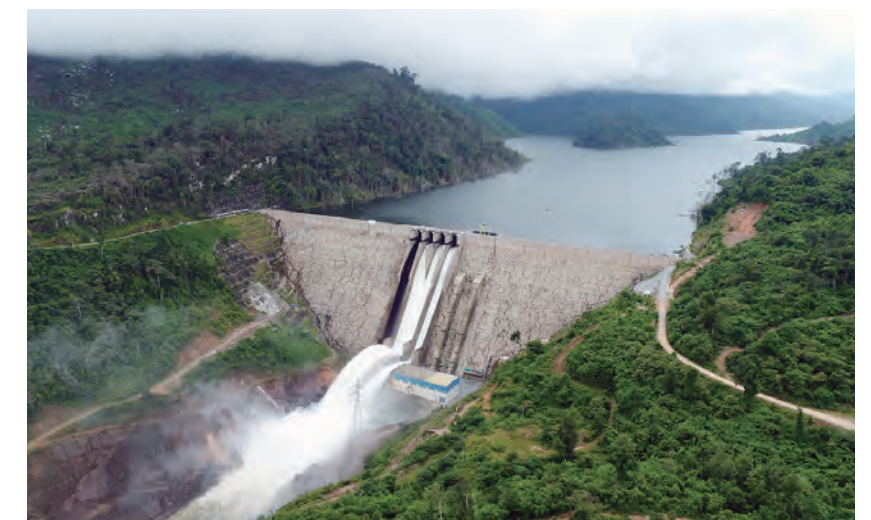
2019 ナムニアップI水力発電所
