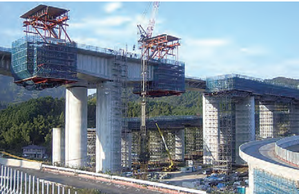
入野高架橋 (静岡県) 構造形式: PC10径間連続波型鋼板ウェブ箱桁橋 橋長: 679.0m 竣工年: 2010年
