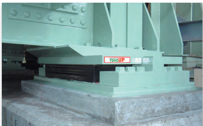
1,000t施工完了例
