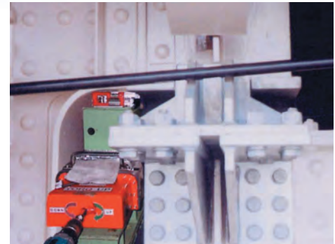
ゲルバー桁施工例
