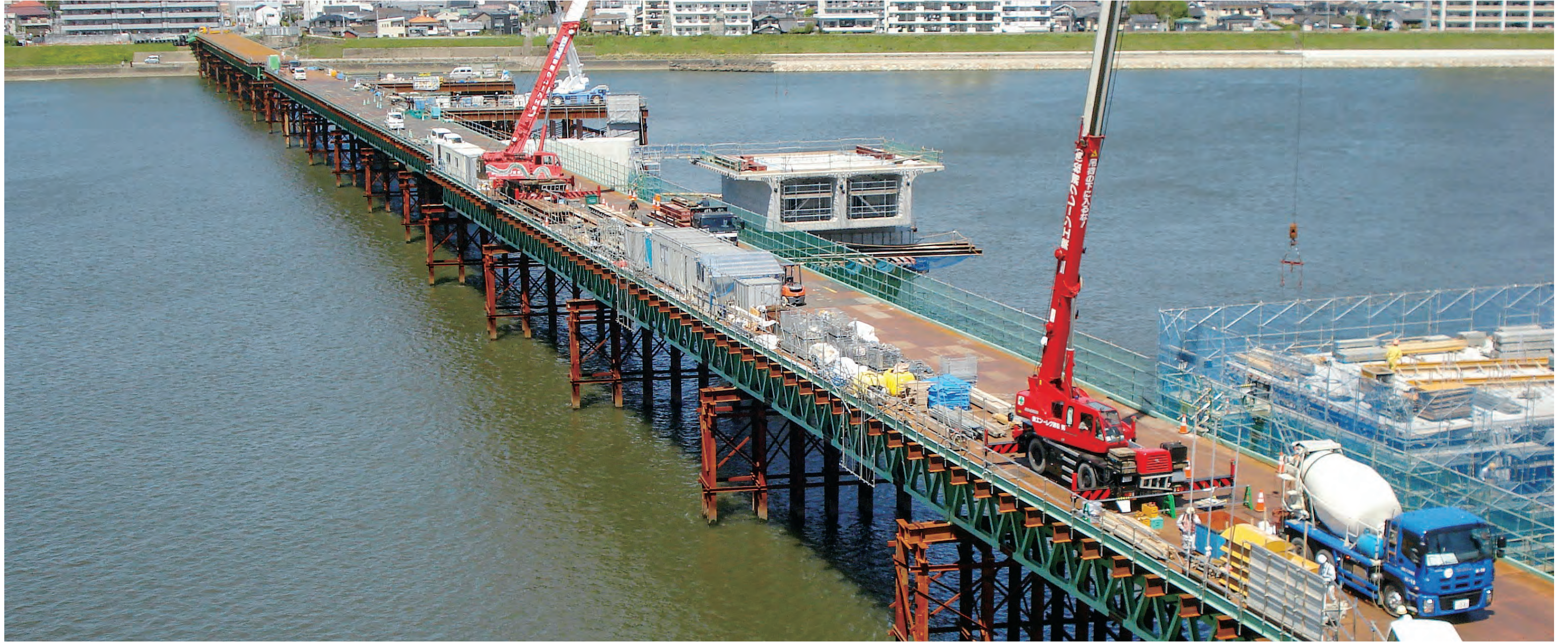
小戸之橋工事用栈橋（宮崎市）
