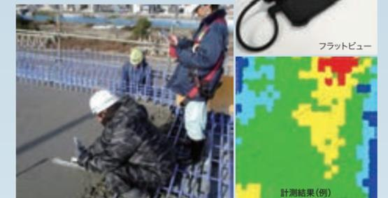
フラットビューは、硬化前のコンクリート表面の平坦度を計測・可視化することができます。表面仕上げの段階に計測することで、左官工に修正箇所を適宜指示することができ、コンクリート硬化後の修正作業の低減が期待できます。
