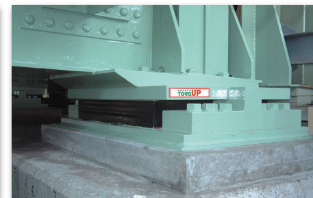
1,000t施工完了例
