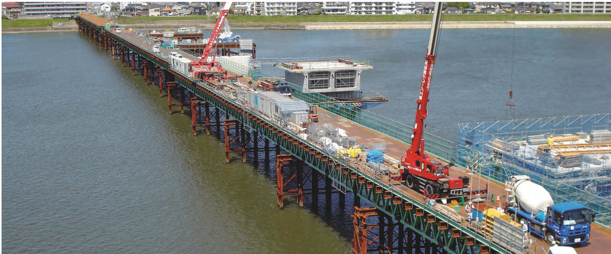
小戸之橋工事用栈橋（宮崎市）
