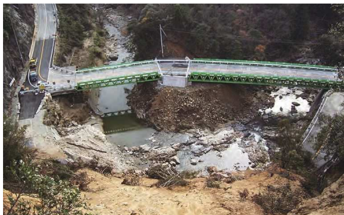
洲本災害復旧仮橋
