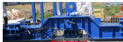
ジャッキ伸縮による水平調整
