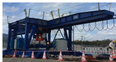
Step2. 床版運搬 (装置走行)
