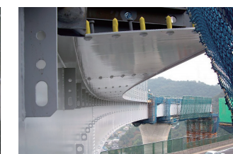
NEXCO西日本殿発注 山陽自動車道 尾道ジャンクション橋工事
