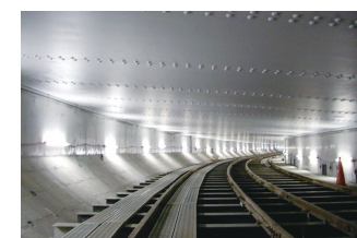
首都高速道路(株)殿発注 中央環状新宿線 大橋トンネル工事
