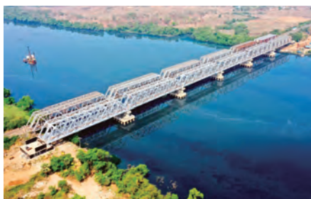
15A工区完成全景
