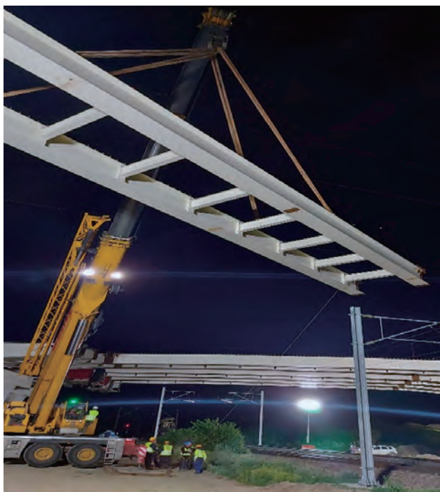
写真-17 跨線橋・桁架設状況
