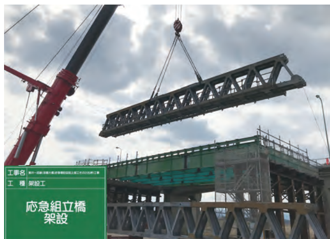
写真-3 トラスタイプ架設
