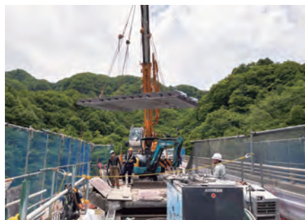
写真-4 スーパー HSLスラブ架設
