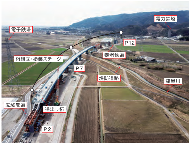
写真-1 施工箇所状況
