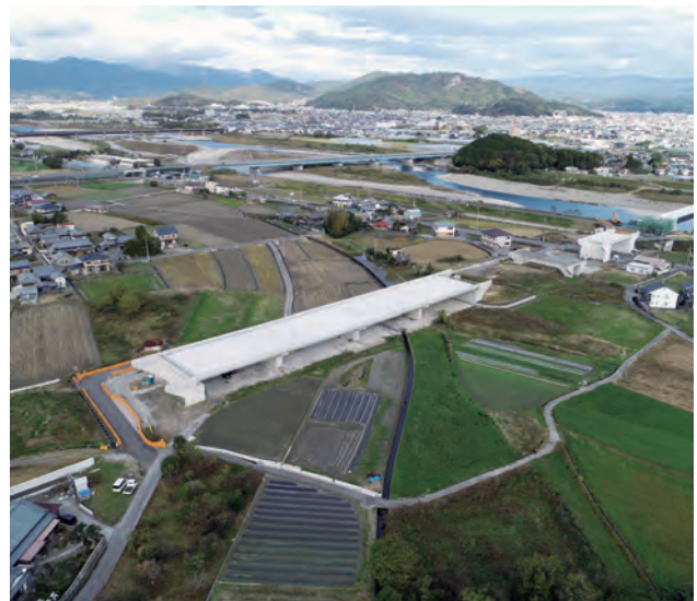
写真-3 茨西高架橋全景
