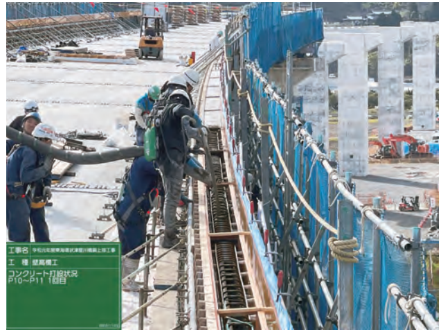
写真-11 壁高欄打設状況
