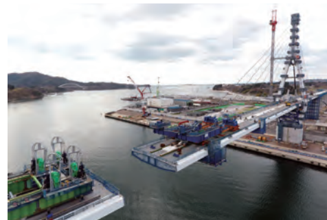
写真-2 桁の架設
