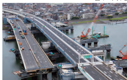
写真-4 新設橋横取り後
