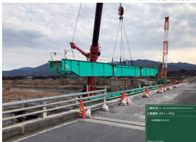
写真-4 鉸桁タイプ架設
