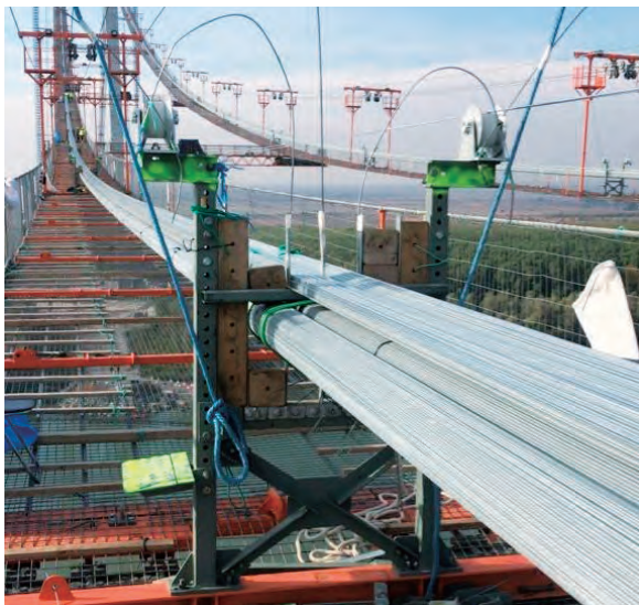
写真-11 ケーブルフォーマーによるワイヤ支持状況
