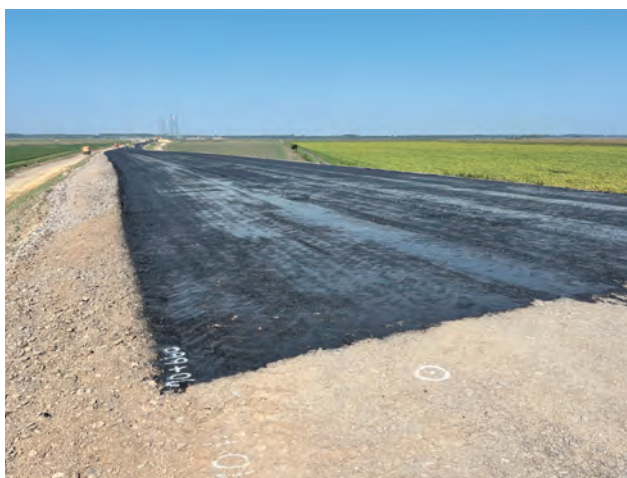
写真-10 アスファルト施工前の瀝青プライマー
