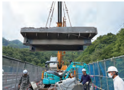
写真-3 アンダーデッキパネル撤去
