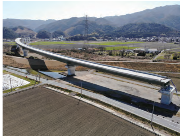
写真-12 施工完了
