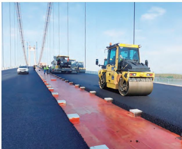
写真-30 舗装の施工状況
