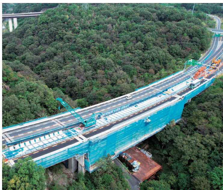
⑦ 幅員方向分割床版取替施工した深沢橋
