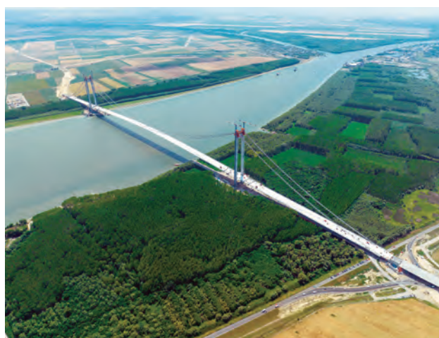
写真-21 架設現地 俯瞰写真
