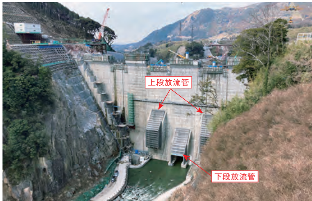
写真-1 立野ダム全景(令和5年2月時点)
