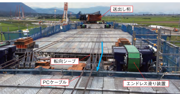
写真-5 PCケーブル展開状況
