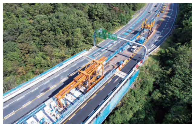
写真-3 床版取替機「EVO」施工状況
