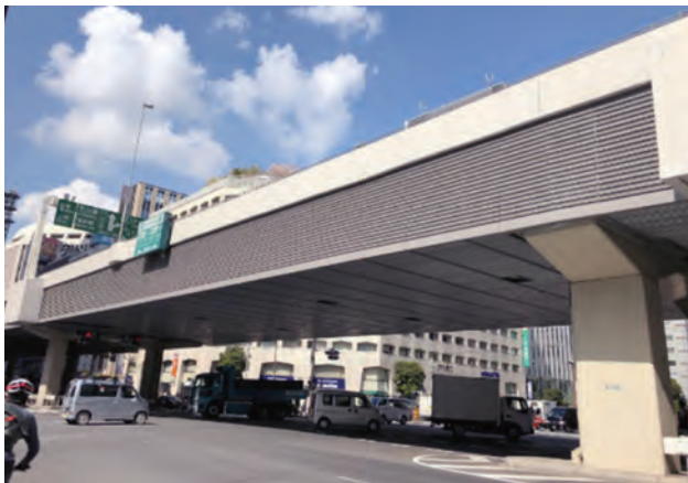
写真-1 首都高速での常設足場施工実績
