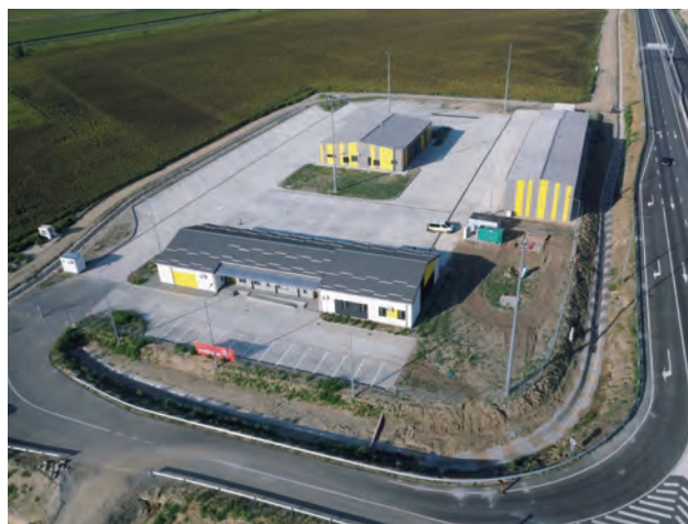
写真-19 コントロールセンター
