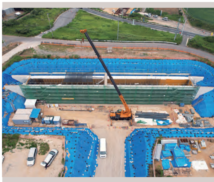
⑤ 支間長最大級のPC単純箱桁橋である清水地区跨道橋
