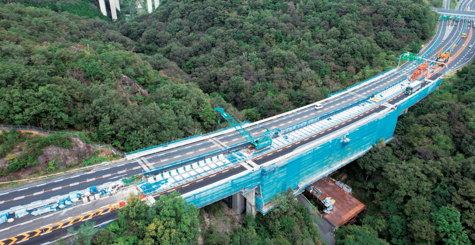
写真-1 深沢橋工事全景
