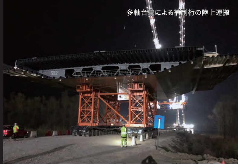
補剛桁閉合ブロック架設
