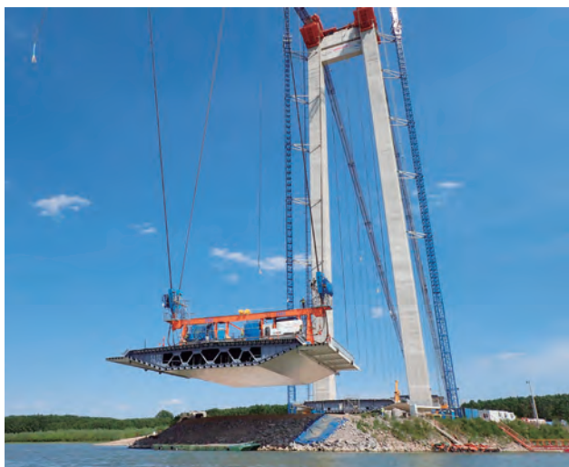
写真-22 荷揚げ状況
