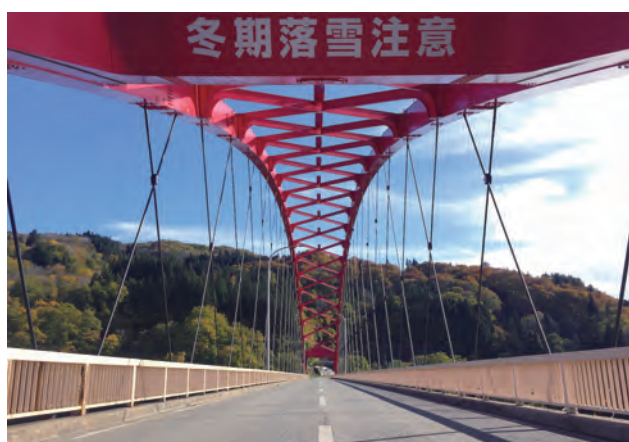
写真-3 橋梁全体写真(施工後)
