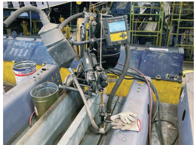
写真-8 サブマージアーク溶接によるパネル板継状況
