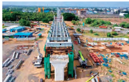
建設中の現場
