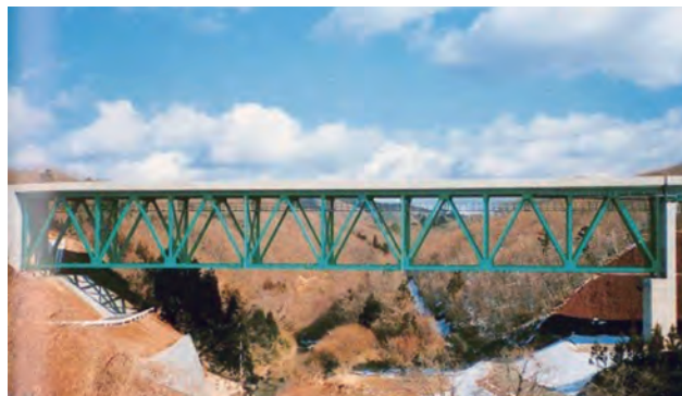
写真-1 単純上路トラス橋(道路公園：南田原井橋)
