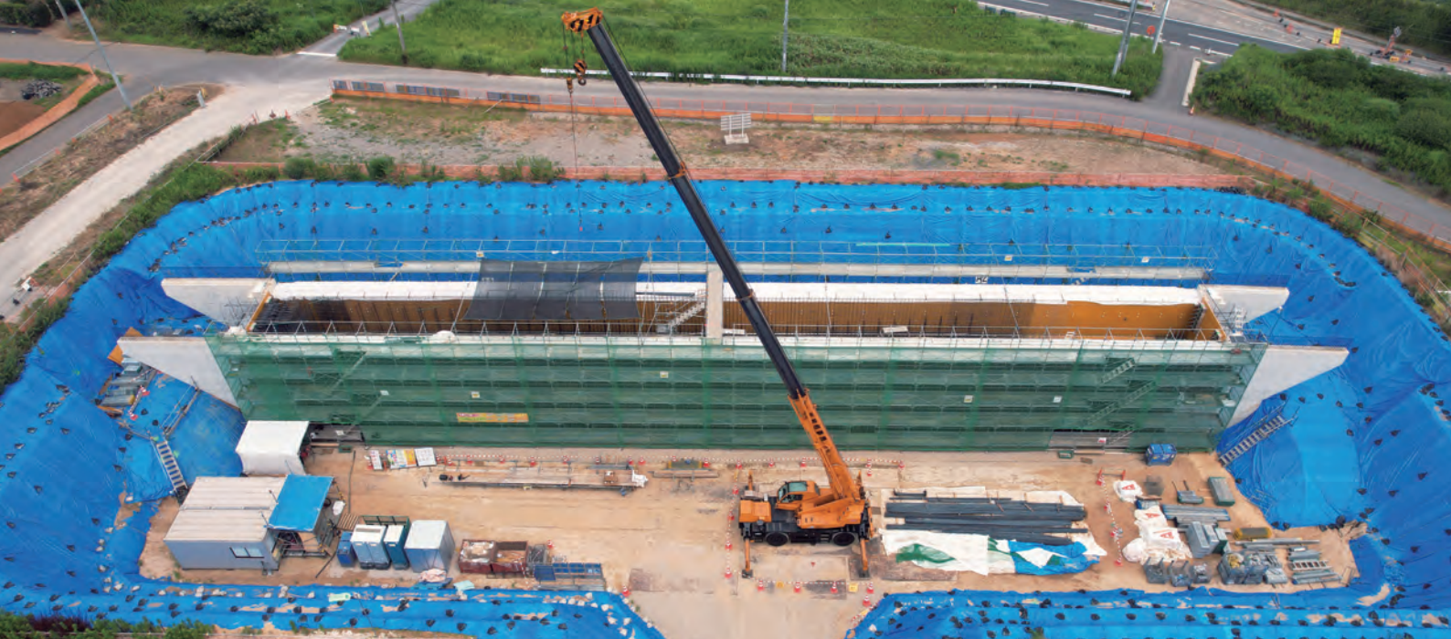
写真-1 工事全景
