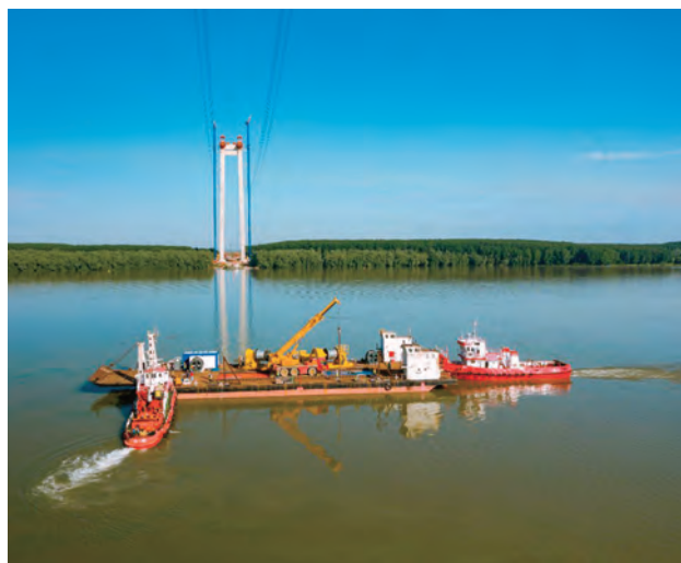
写真-7 CWロープ沈設渡河状況
