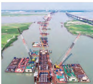
橋脚と上部工の建設
