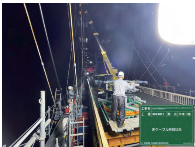
写真-2 ケーブル取替え状況
