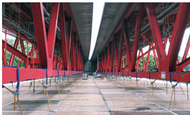
写真-3 クイックデッキ組立状況
