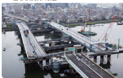
写真-3 既設橋横取り後
