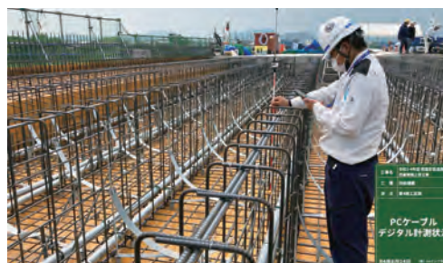
写真-1 PCケーブルTS計測状況
