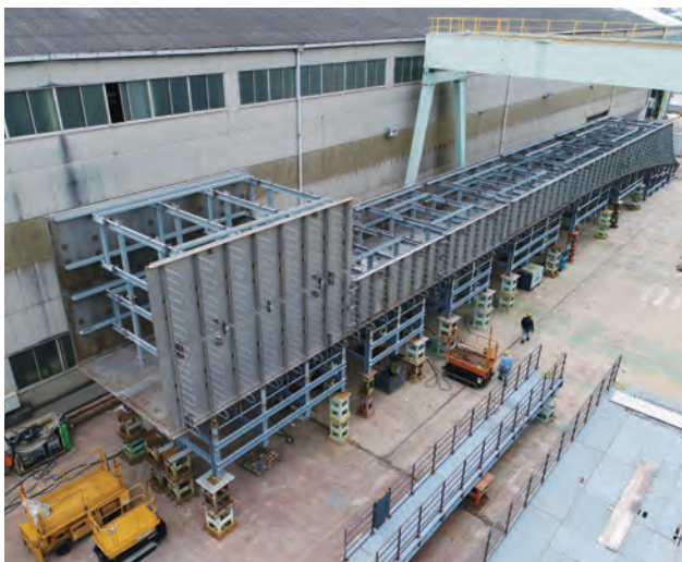
写真-5 下流開水路部整流板 仮組立状況
