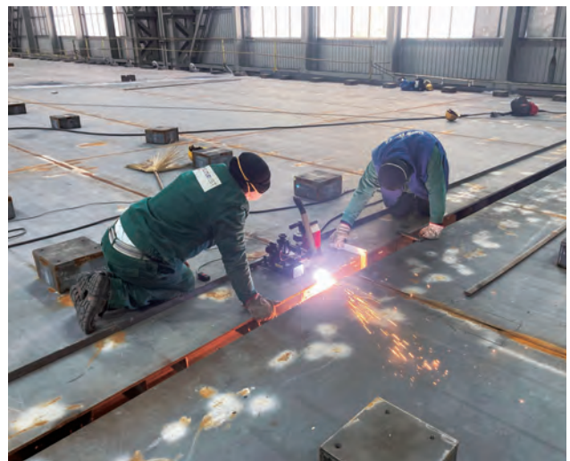
写真-16 デッキPL2次切断状況
