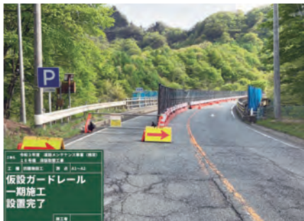
写真-2 仮設ガードレール設置
