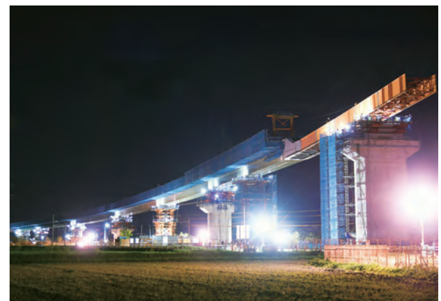
写真-8 5回目の送出し状況
