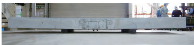
(a)試験体全体
