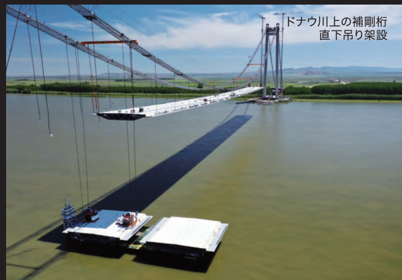
各径間で並行する補剛桁架設
