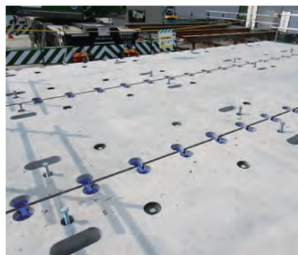
写真-10 接合完了
