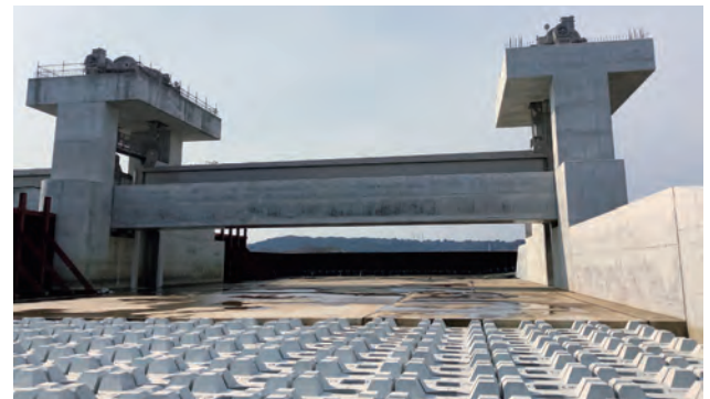
写真-2 全景写真(下流視)
