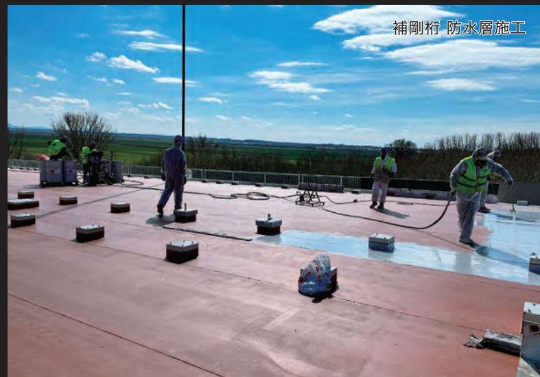
アスファルト施工
