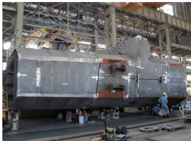
写真-1 上段水平梁隅角部+塔柱 一体確認組立状況
