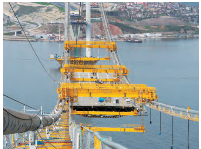
写真-25 オスマン・ガーズィー橋 直下吊り設備 (メインケーブル集約型)
