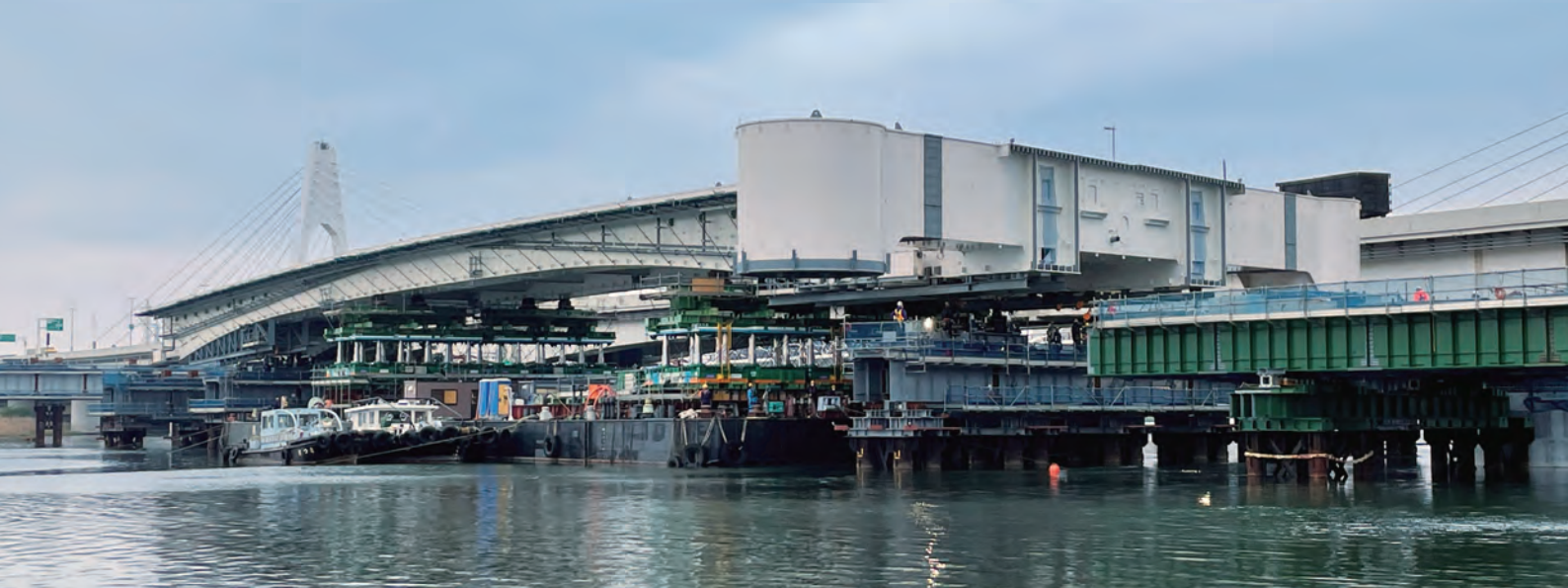
写真-1 台船リフトアップ架設
