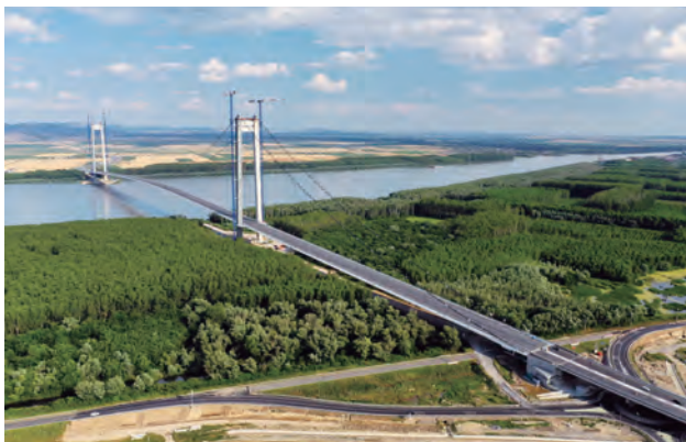
写真-1 ブライラ橋全景
