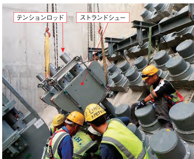
写真-5 ストランドシュー 架設状況
