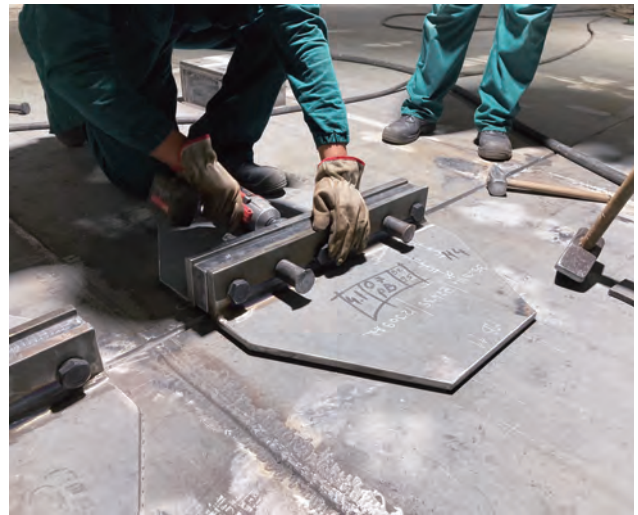
写真-15 現地架設用マッチングピース(デッキ面)
