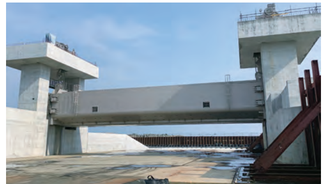
写真-1 全景写真(上流視)
