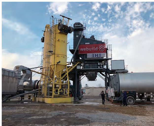
写真-12 JVアスファルトプラント
