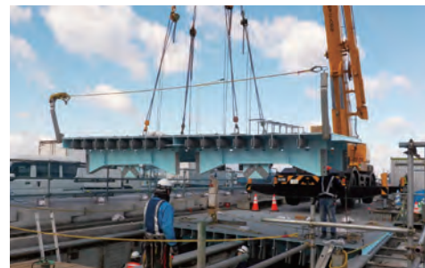
写真-3 鋼床版の架設
