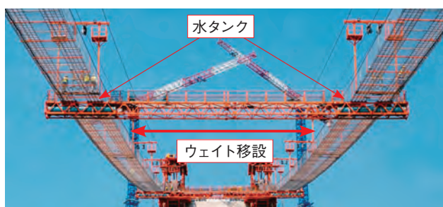
写真-12 クロスブリッジ上ウェイト移設
