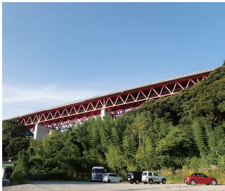
⑥ トラス橋の大規模補修補強工事である向田川橋
