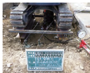
写真-10 平板载荷試験
