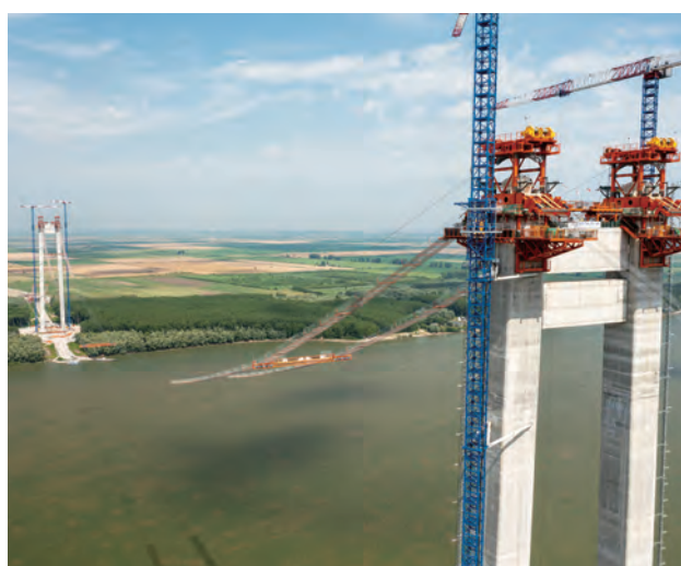
写真-8 CW連続床出し状況
