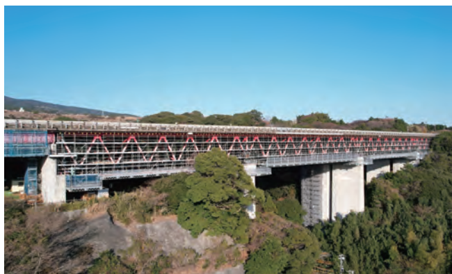
写真-2 吊足場設置完了
