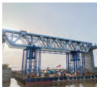
15B工区台船架設
