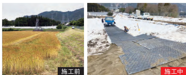
写真-8 千手局仮設通路(施工前後)
