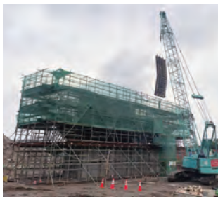
Zathapyin主塔の型枠施工
