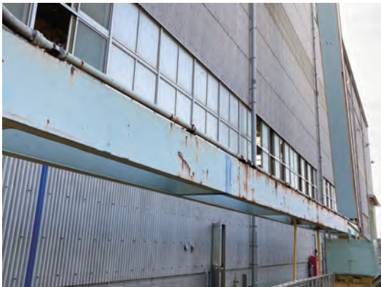
写真-4 施工性能確認試験にて使用した実構造物
