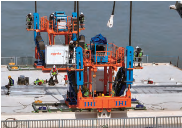
写真-26 直下吊り設備 桁上ユニット
