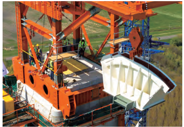
写真-2 塔頂サドル架設状況
