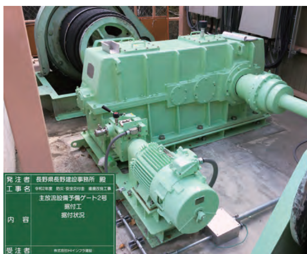
写真-3 現地据付完了
