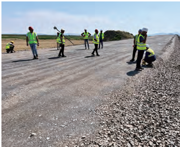
写真-9 路盤施工後の立会検査
