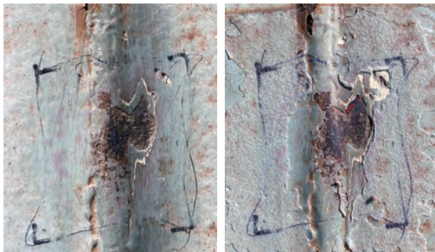
貼付け直前 貼付けから1年経過後 図-9 貼付型防食部材の貼付け直前と 貼付けから1年経過後の塗装鋼面の外観写真
