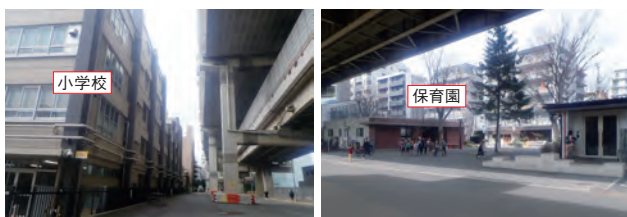
写真-1 高架下・近隣状況
