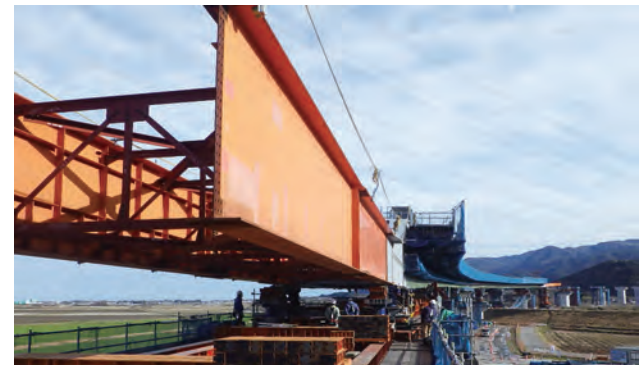
写真-6 後方手延べ機状況(手延べ機の上げ越し)
