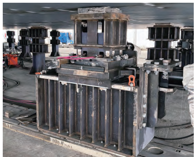
写真-17 油圧ジャッキによる位置調整機能付サポート
