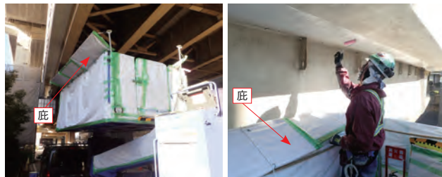
写真-3 高所作業車庇設置状況
