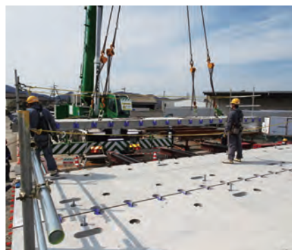
写真-7 クレーンによる床版架設
