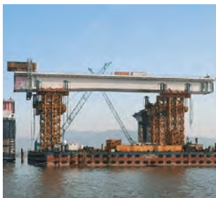
台船によるブロック架設
