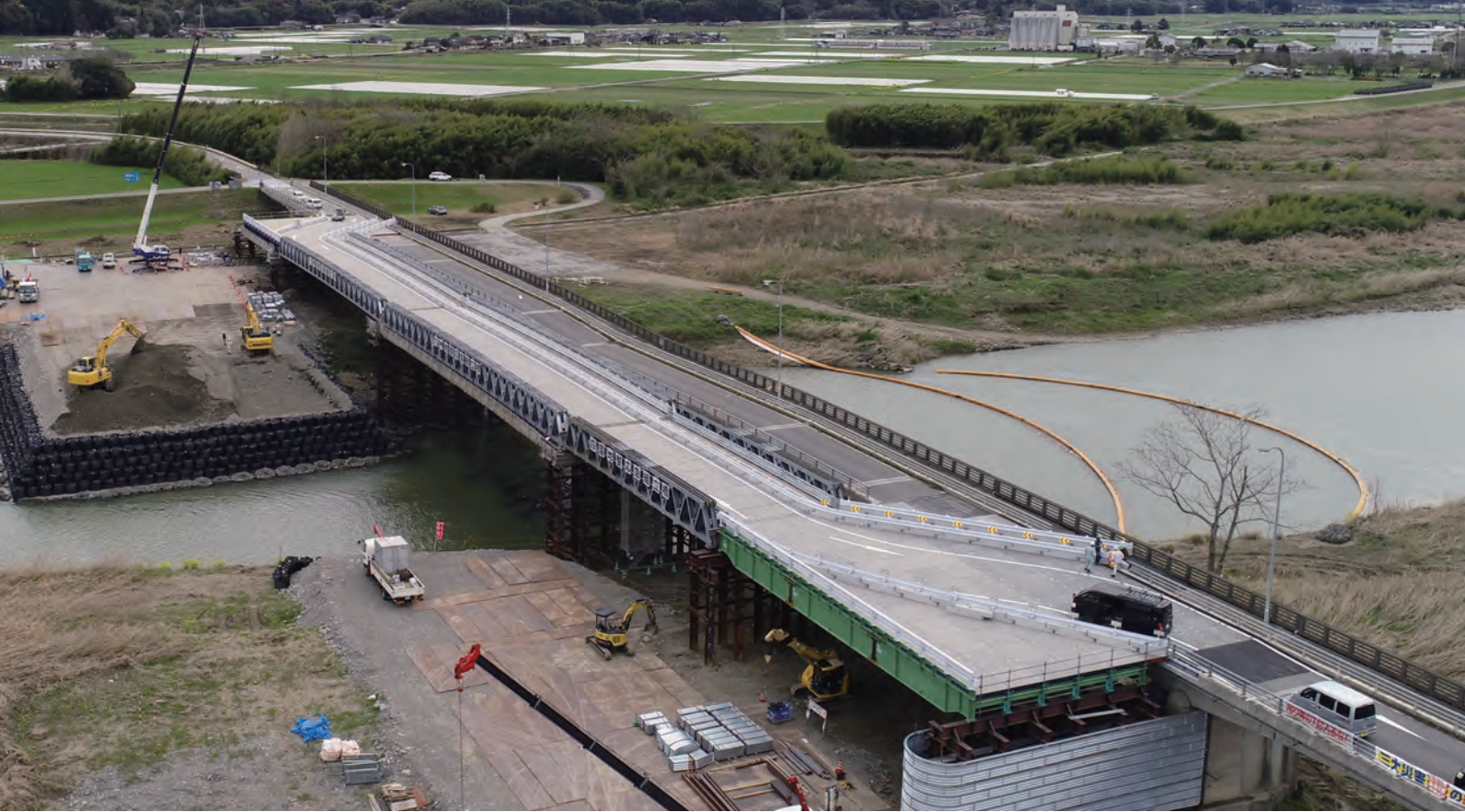
写真-1 仮橋全景
