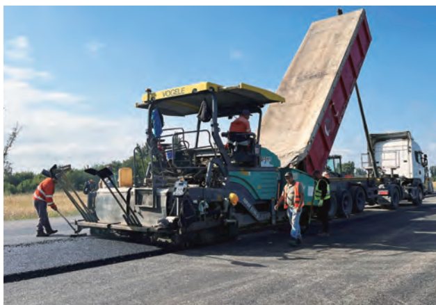
写真-11 アスファルト舗装
