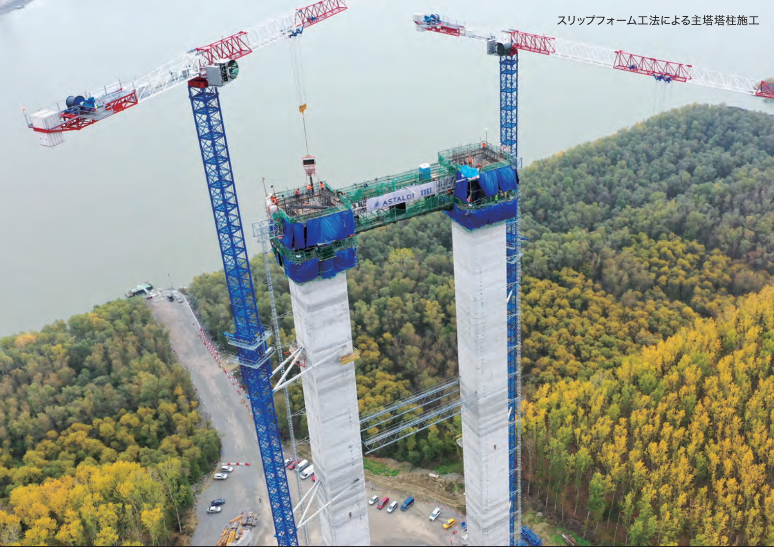
塔頂水平梁の吊上げ
