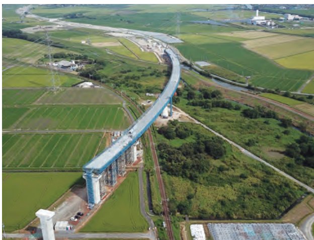
写真-10 桁架設完了
