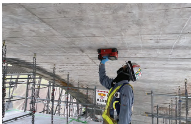
写真-3 アーチリブ鉄筋探査状況
