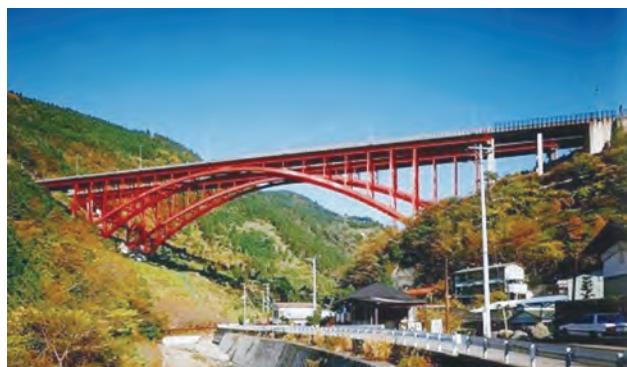
写真-2 上路アーチ橋(道路公園：皆瀬川橋)
