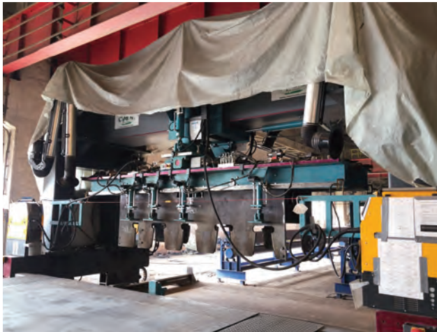
写真-3 トラフ位置決め用テンプレート
