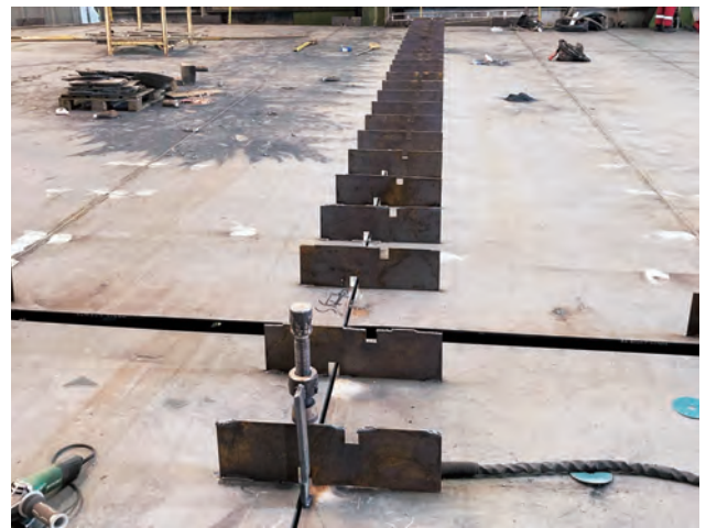
写真-12 溶接歪拘束用プレート
