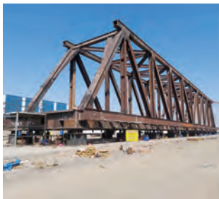
現地工場での仮組立て
