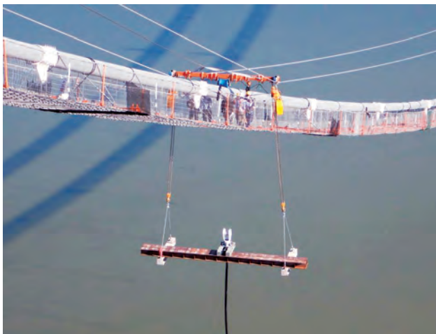
写真-15 ハンガー運搬状況
