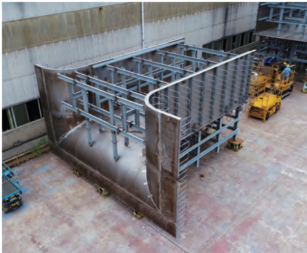
写真-4 呑口部整流板 仮組立状況
