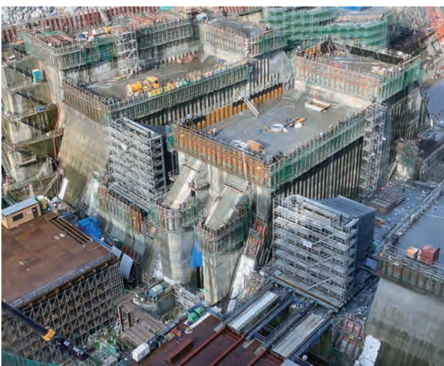
写真-12 放流管引込み完了
