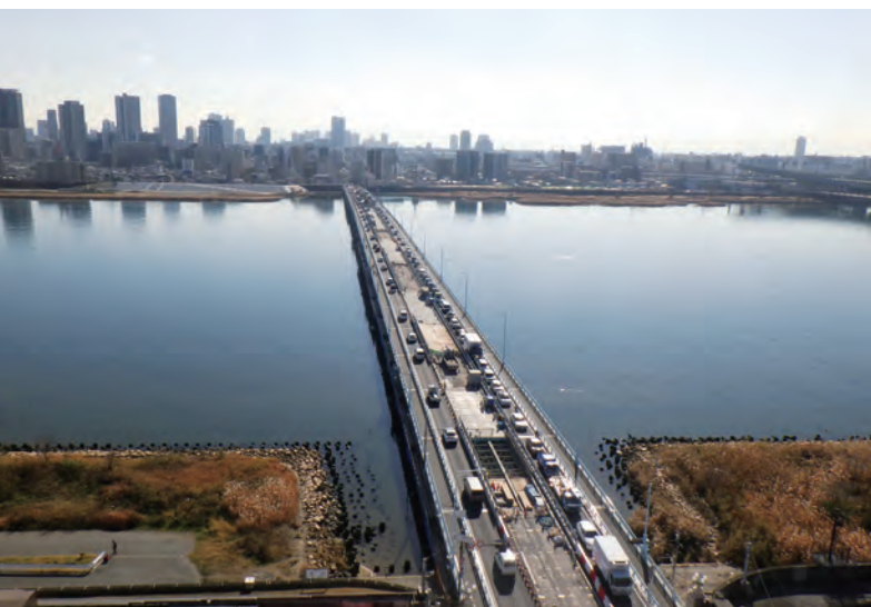
写真-4 床版の更新
