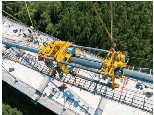
写真-16 ケーブルラッピング状況
