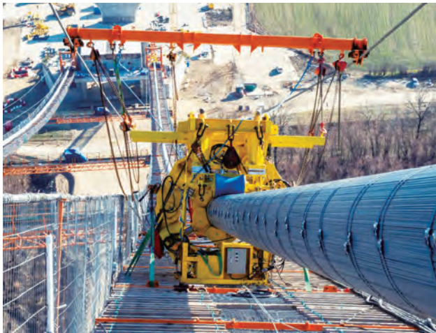
写真-14 ケーブルコンパクション状況
