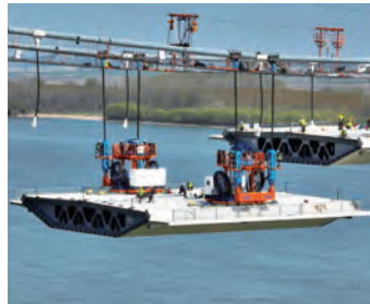
ストランドジャッキによる桁架設
