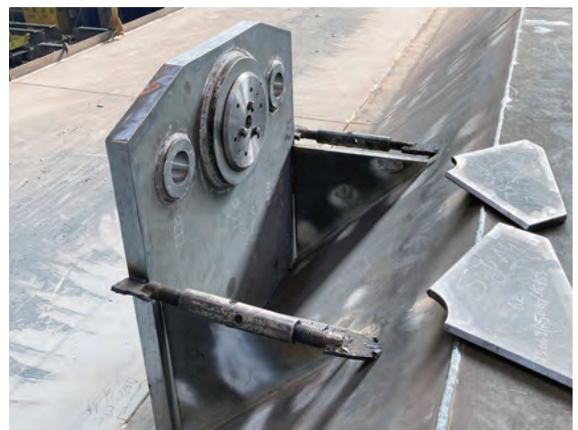
写真-13 ハンガープレート取付け状況
