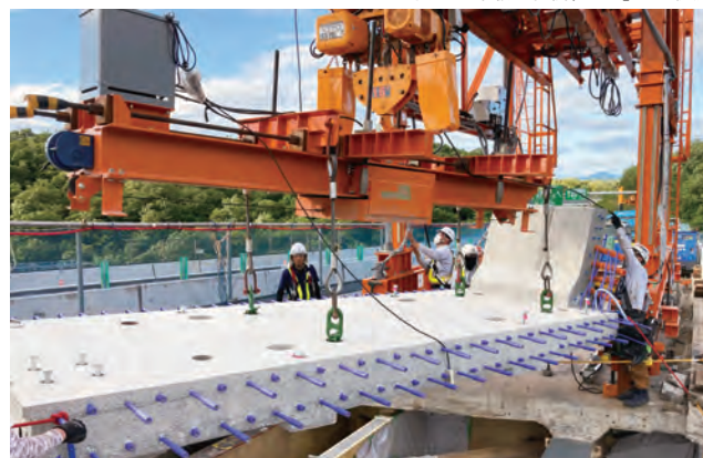
写真-4 床版取替機「EVO」施工状況
