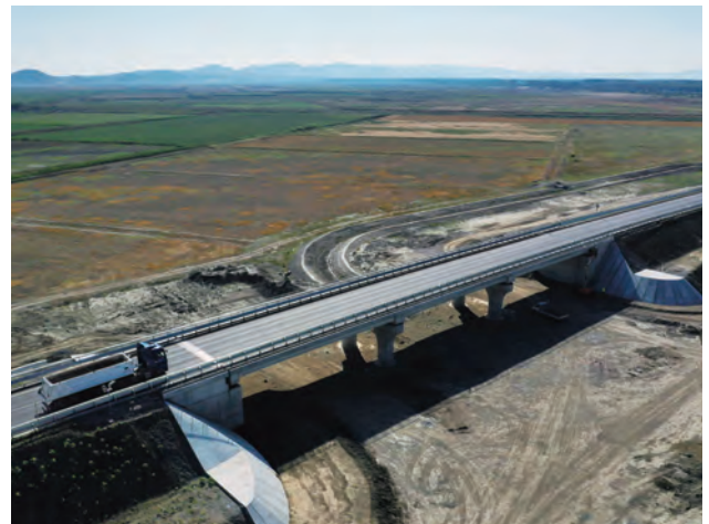
写真-16 PC桁橋(接続道路km3+507)
