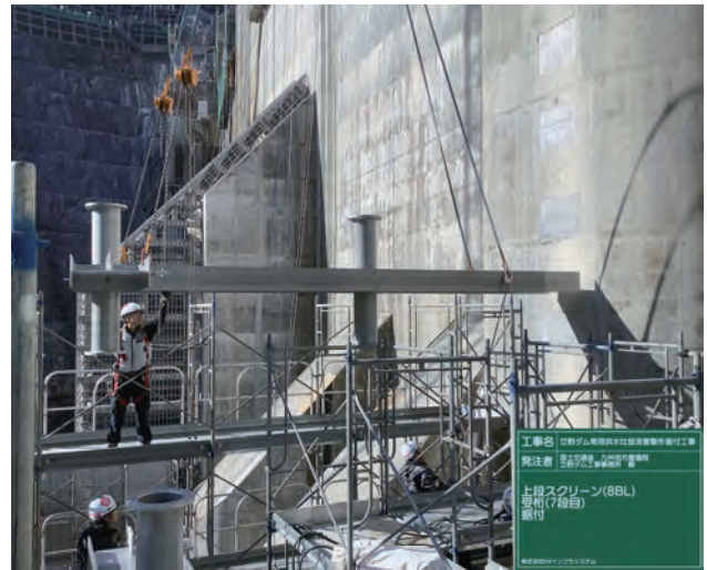
写真-13 受桁据付状況
