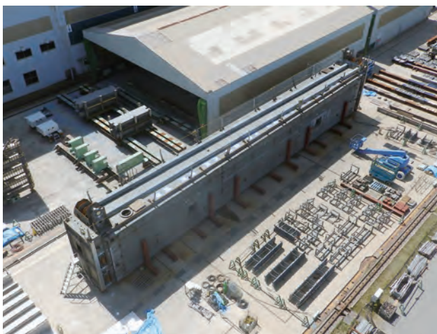
写真-4 仮組立状況
