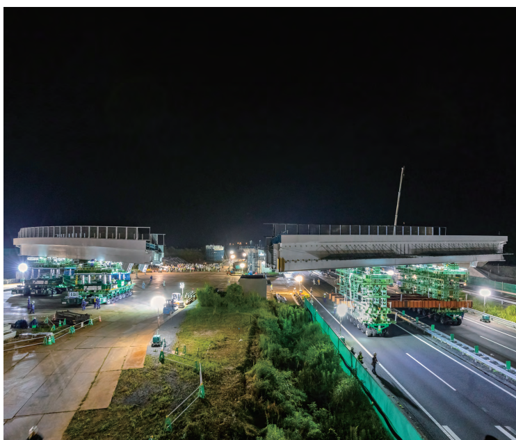
④ 一夜間での2橋同時架設した大栄JCT
