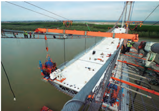
写真-27 直下吊り設備 降下装置
