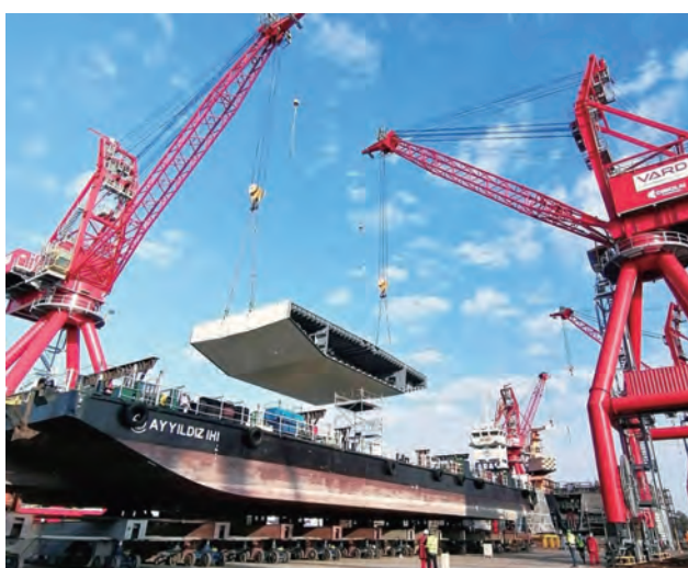
写真-19 ジブクレーンによる相吊り
