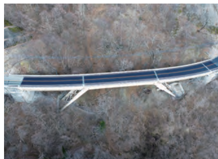
写真-6 完成状況
