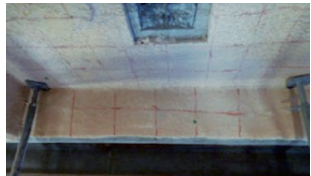
写真-2 鉄筋探査、断り出し確認
