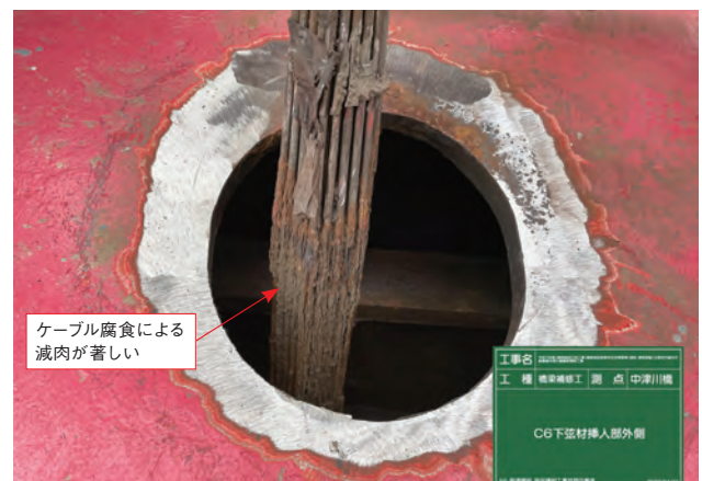
図-7 下弦材内部の既設ケーブル
