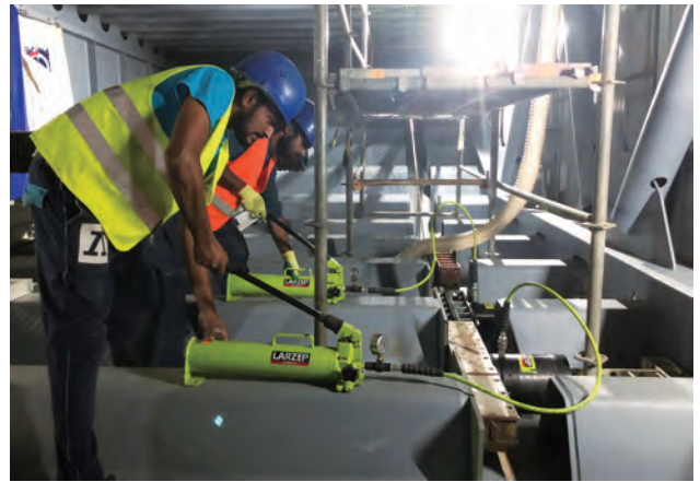
写真-28 仕口調整作業
