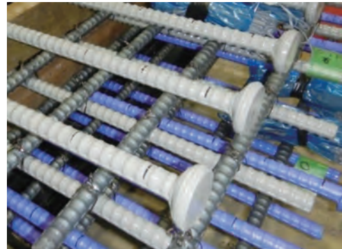
写真-2 Tヘッド工法鉄筋
