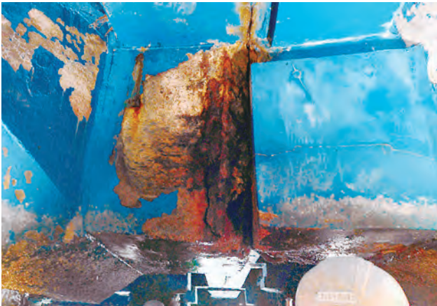
写真-8 周辺部の状況把握 (今回写真・損傷の位置の梁を裏側からも撮影)
