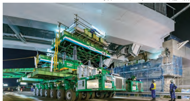
写真-3 多軸台車に搭載した大型ユニットジャッキ
