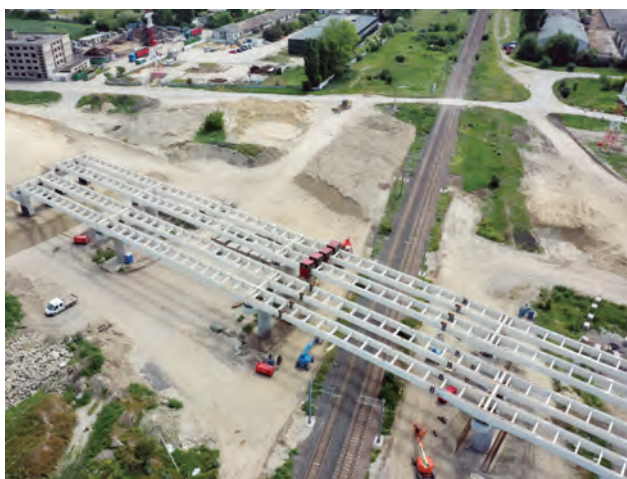
写真-18 跨線橋架設完了後
