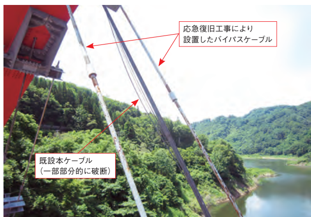
図-4 バイパスケーブルと既設ケーブル
