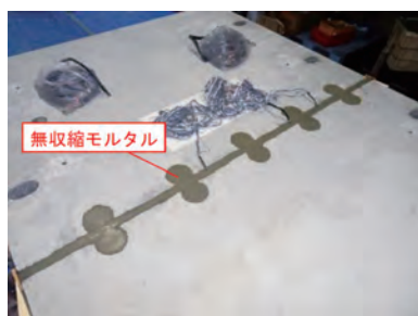
写真-2 無収縮モルタル充填後
