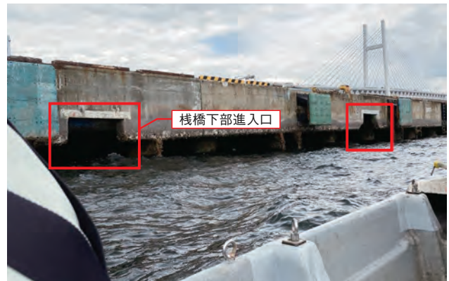
写真-3 床版下面への進入部
