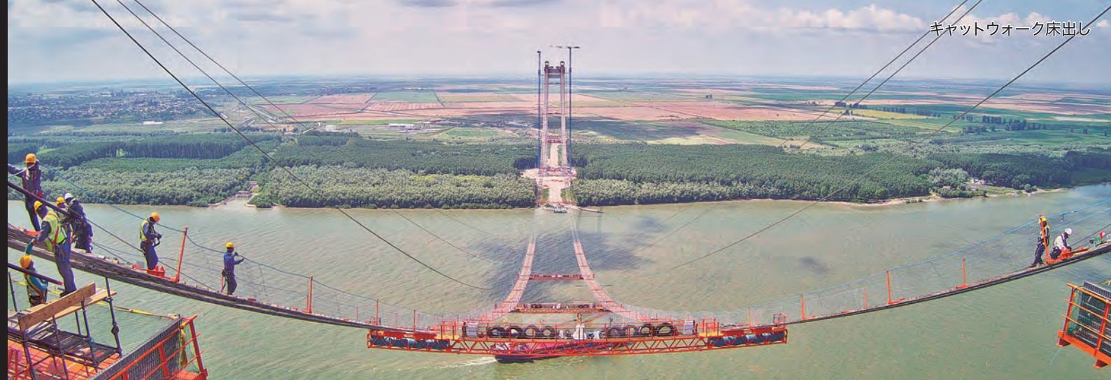
メインケーブル架設時遠景
