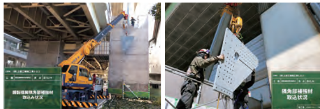
写真-2 補強材取付状況
