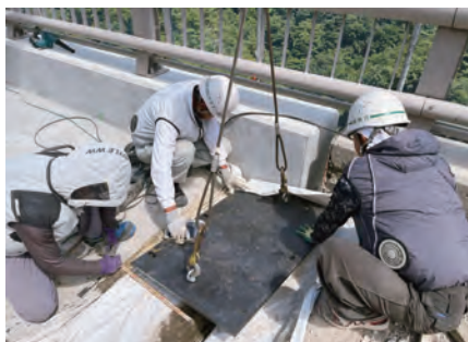
写真-5 伸縮装置部仮覆工
