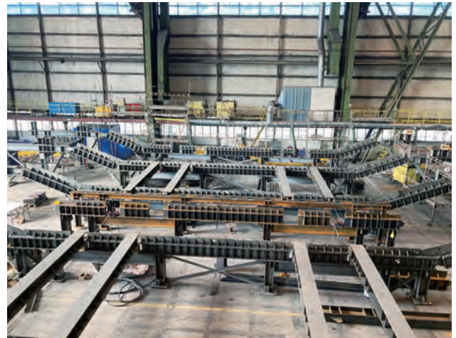
写真-11 ブロック組立定盤
