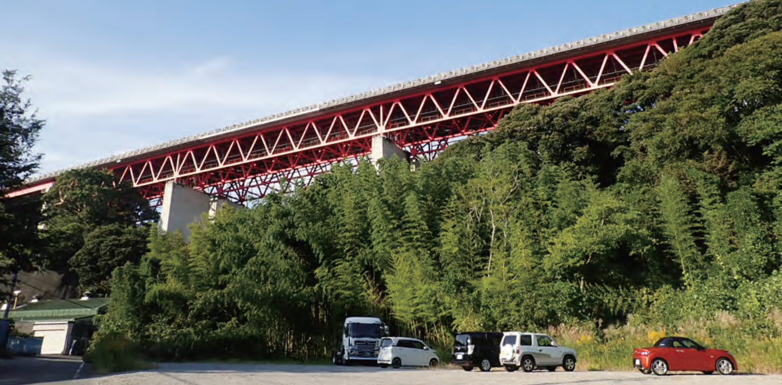
写真-1 根古屋橋全景写真(着手前)
