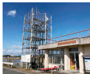
写真-12 足場設置
