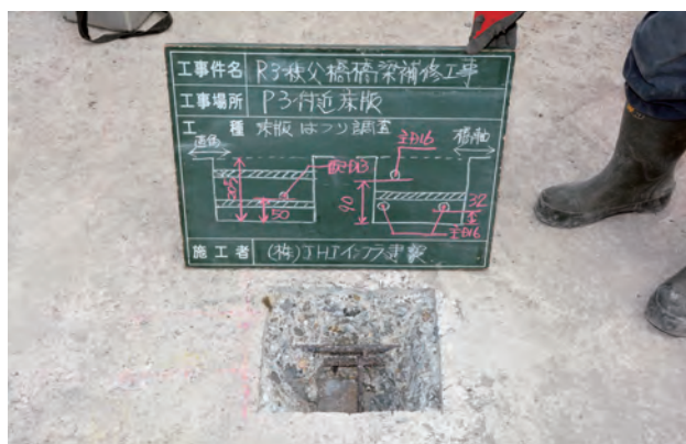
写真-1 上縁部鉄筋確認状況
