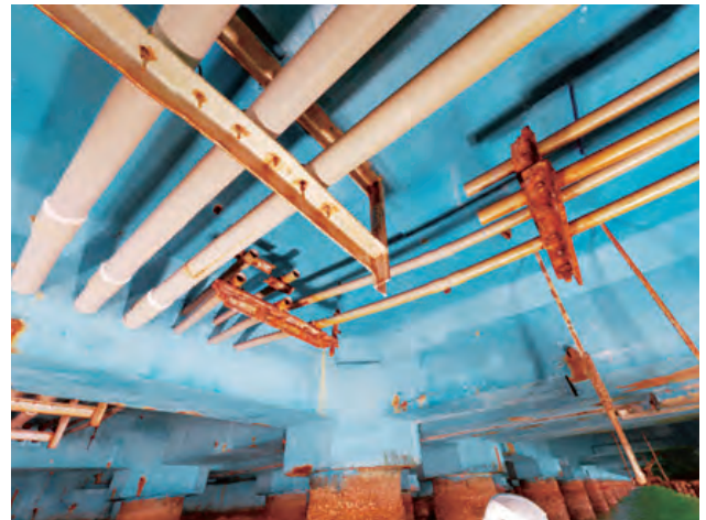
写真-11 添架物の状況(今回写真)
