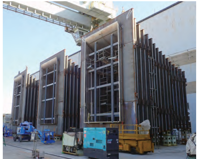
写真-3 上段放流管(左・中央)・下段放流管(右) 仮組立状況
