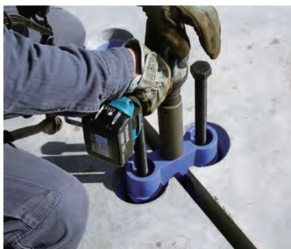
写真-8 架設床版の引き寄せ
