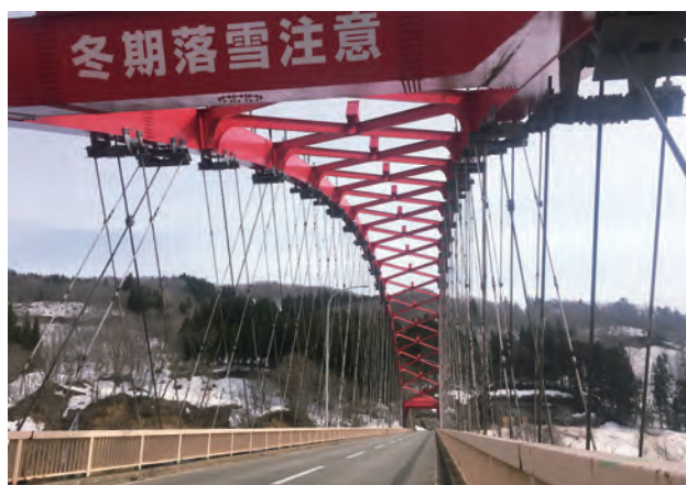
写真-1 橋梁全体写真(施工前)
