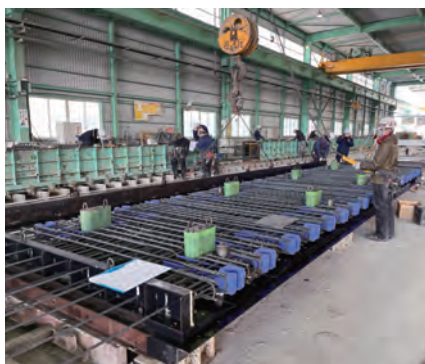
写真-5 床版製作
