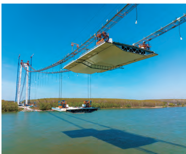
写真-23 直下吊り状況
