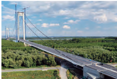
架設完了後、交通解放前の様子
