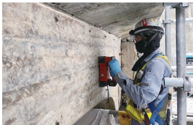
写真-2 主桁下縁部鉄筋探査状況
