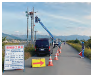
写真-11 高所作業車
