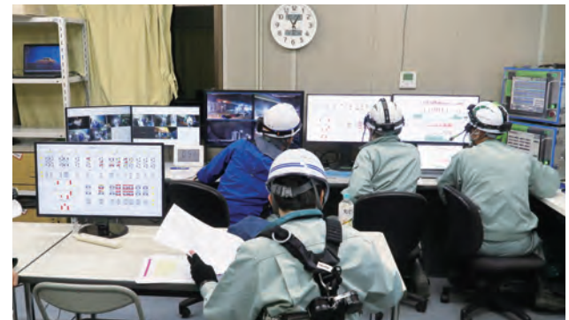
写真-7 集中管理室 反力管理状況
