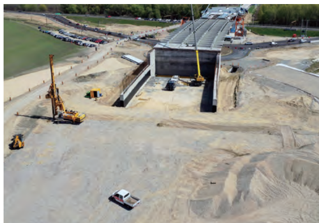
写真-3 ストーンコラム施工
