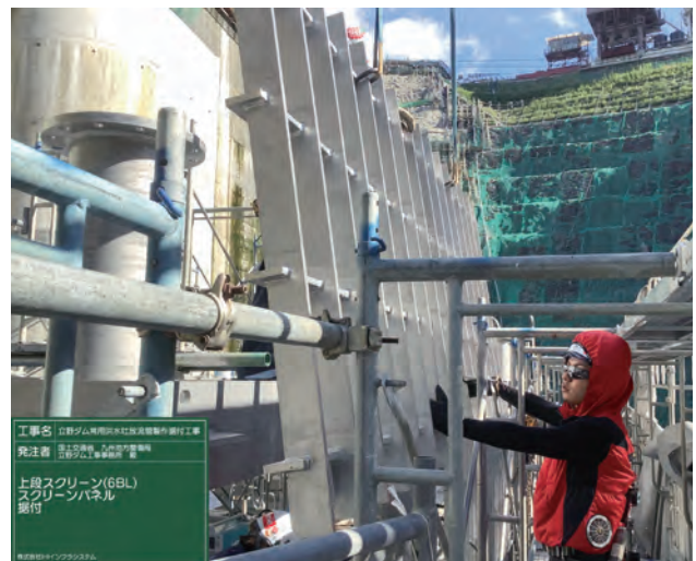
写真-14 スクリーンパネル据付状況
