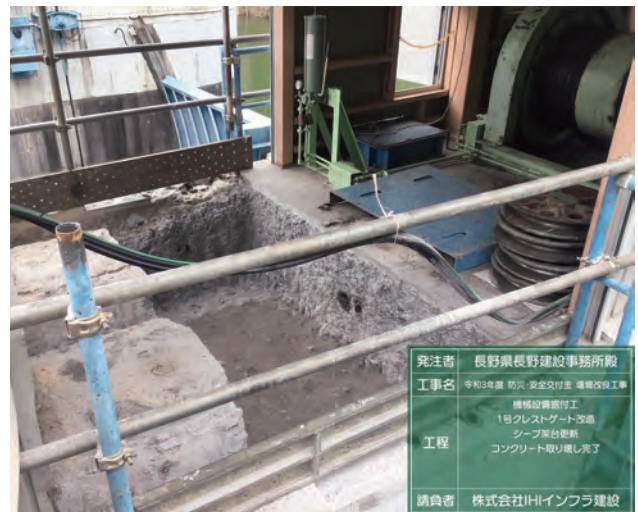
写真-5 コンクリート取壊し完了
