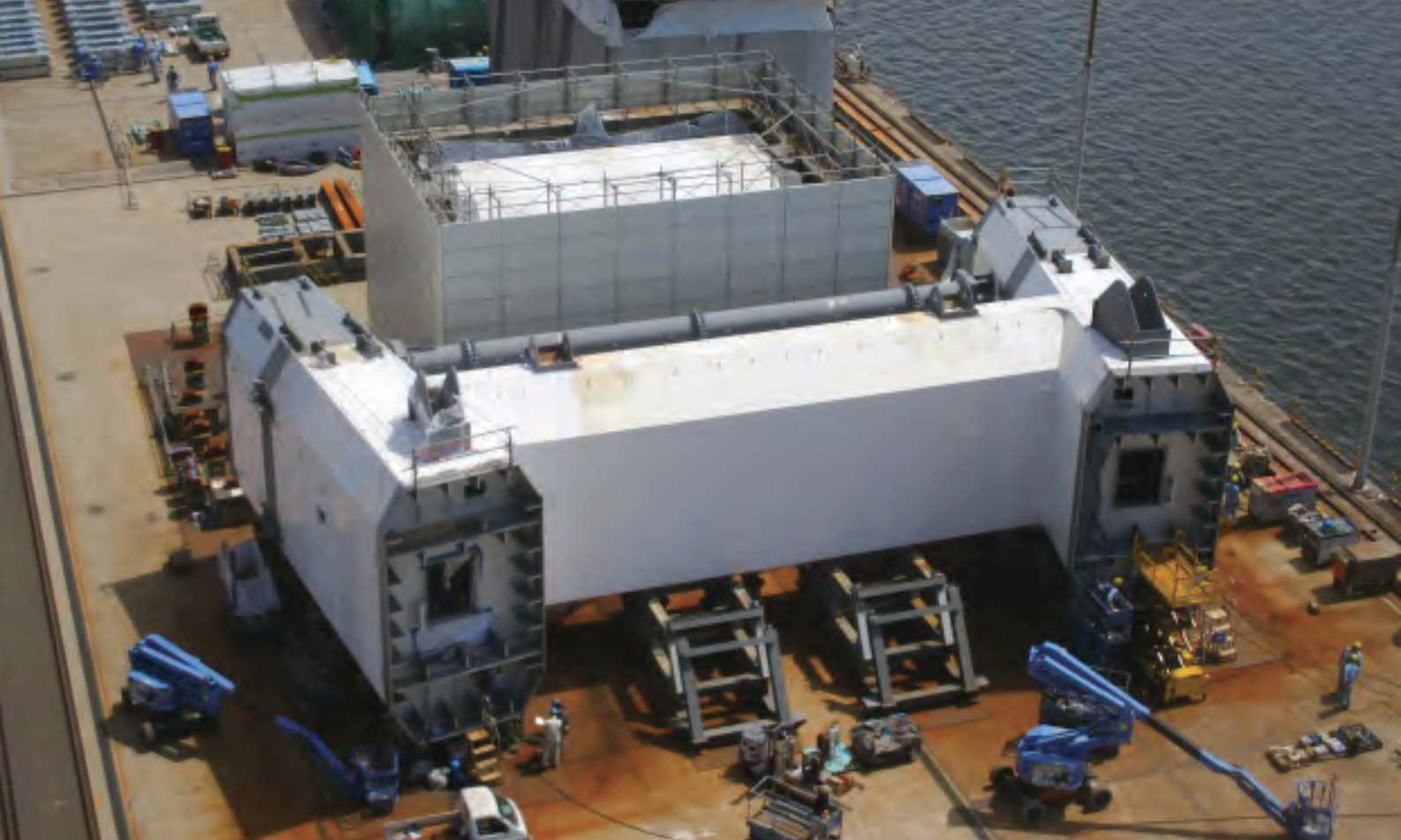
写真-3 JFEへの転送ブロックの輸送前の最終仕上げ状況
