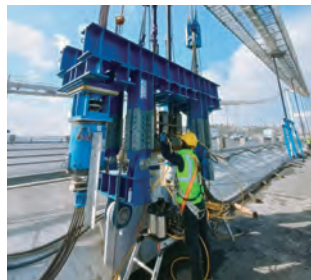
ハンガーケーブル交換作業
