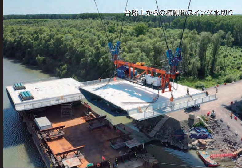
主塔部補剛桁 メガブロック架設
