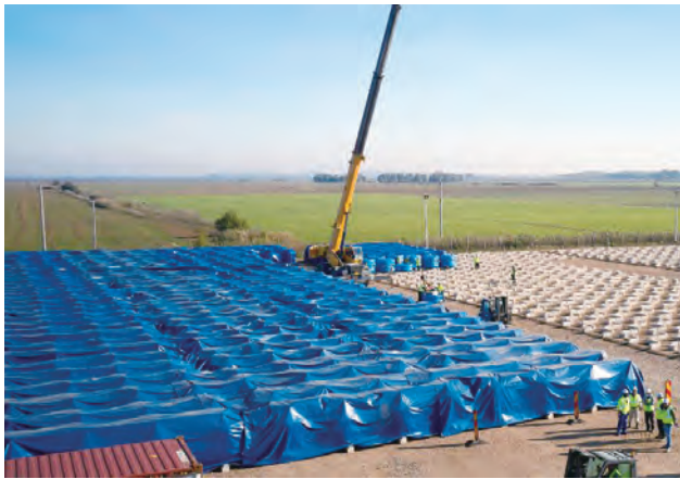
写真-1 ワイヤコイル保管状況
