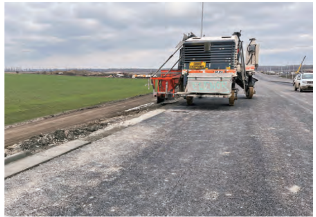
写真-24 路肩部排水溝の連続打設機
