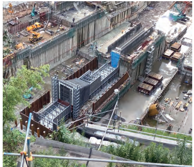
写真-9 放流管、整流板据付完了
