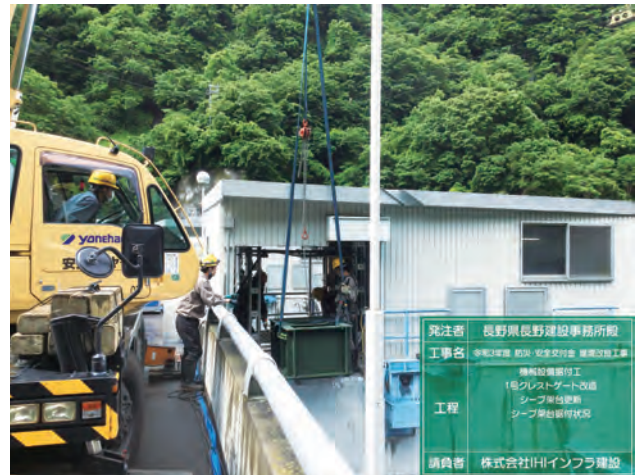
写真-4 シーブブロック据付状況
