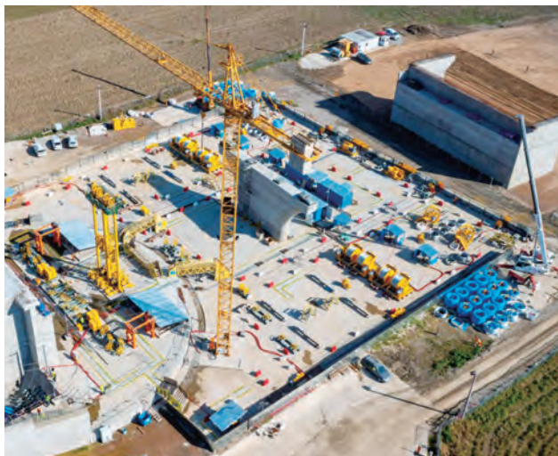
写真-9 ASヤード全景
