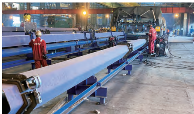
写真-2 トラフ溶接治具
