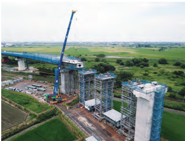
写真-9 側径間部架設状況
