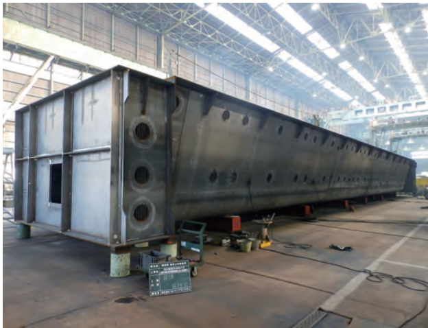
写真-3 水平状態での仮組立状況
