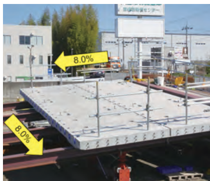
写真-6 縦断・横断勾配8%状況
