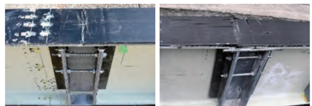
(a) 横桁3点曲げ載荷(ケース1) (b) 横桁4点曲げ載荷(ケース2)
