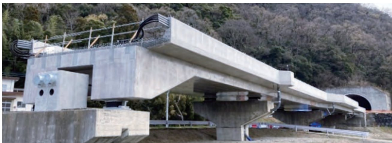
写真-4 完成写真(起点側より)
