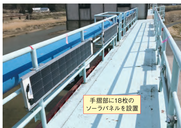
写真-4 ソーラパネルモジュール設置状況
