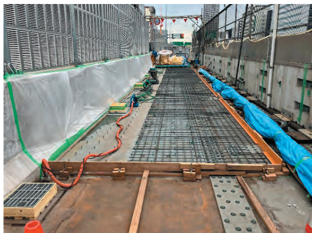
写真-13 スタッド・CFRP格子筋配置
