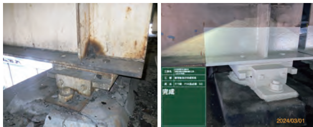
写真-1 塗装補修工の施工前・施工後
