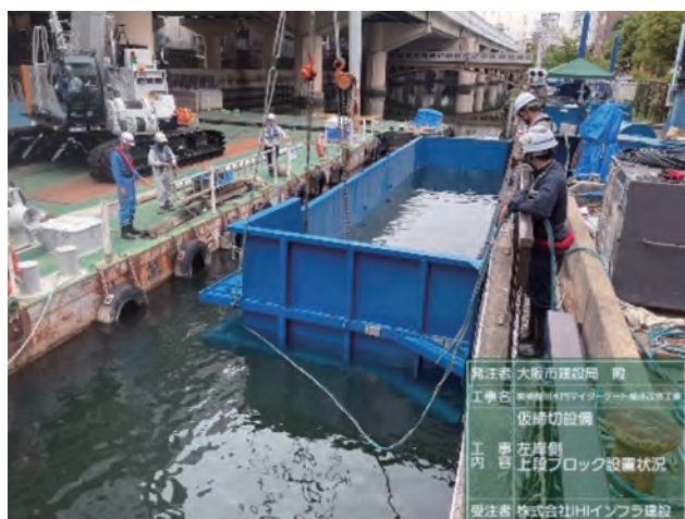
写真-10 左岸側仮締切設置
