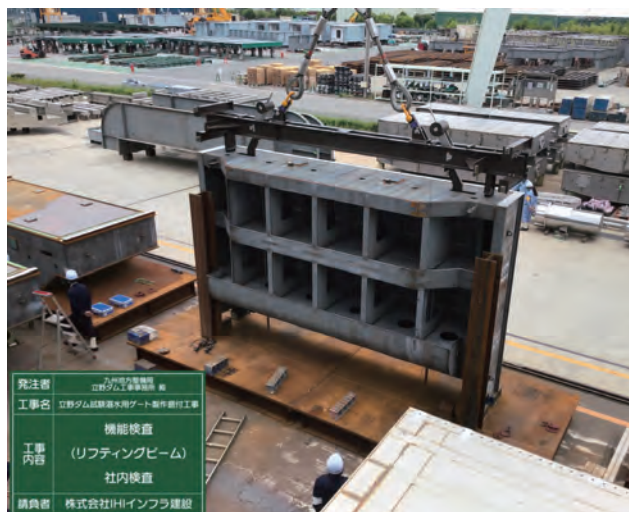
写真-2 リフティングビーム自動着脱確認状況
