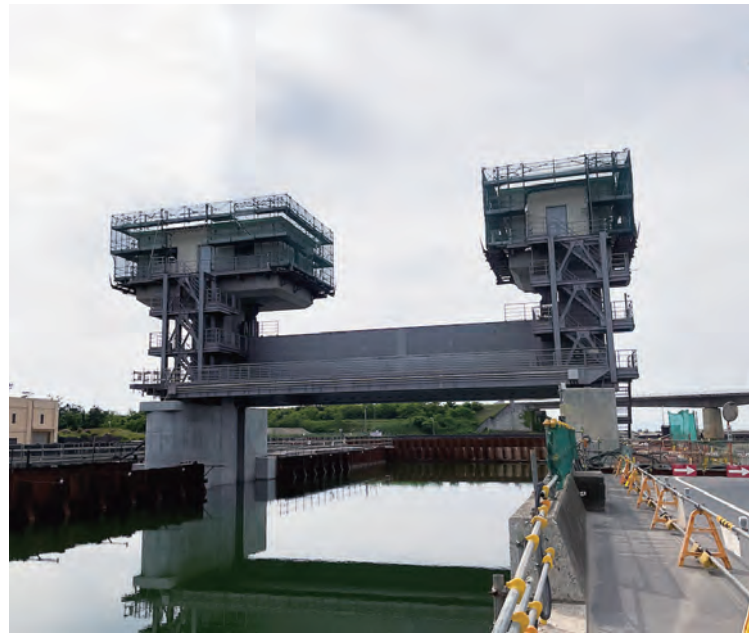
④ 新川河口自然排水樋門
