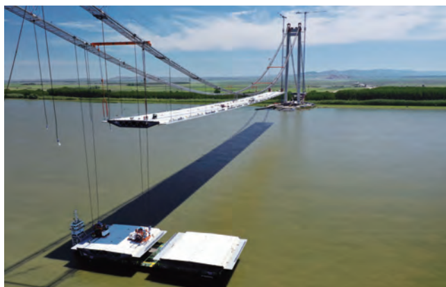
写真-2 ドナウ川上の補剛桁直下吊り架設
