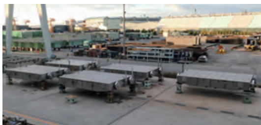
写真-3 工場仮組立
