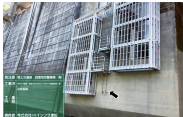
写真-2 点検タラップ外観
