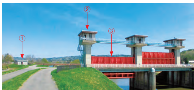
写真-1 元宿川水門
