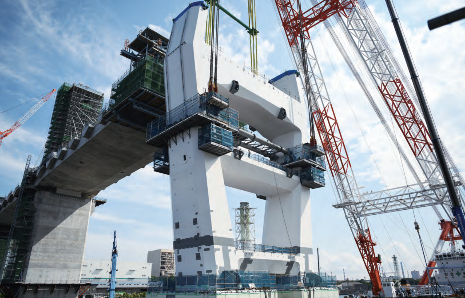
写真-4 中段ブロックの架設状況
