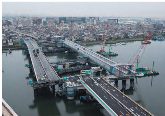
写真-2 既設橋横取り後（提供：首都高速道路株）
