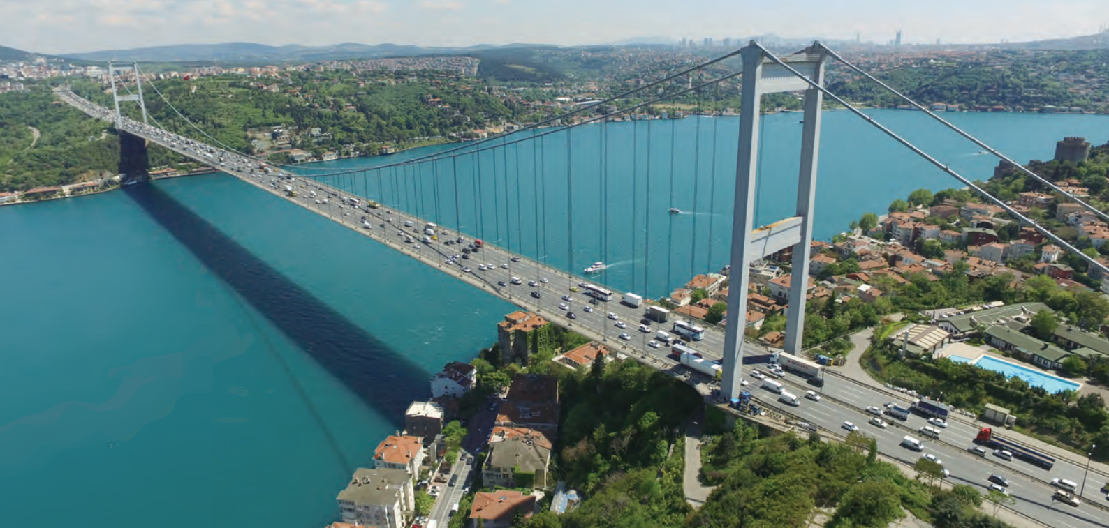
写真-1 第2ボスポラス橋全景
