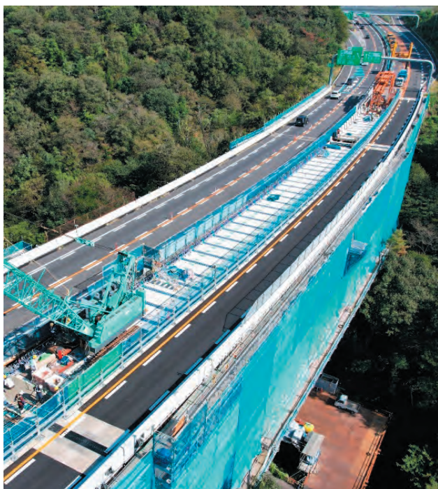
写真-8 追越車線側床版取替状況
