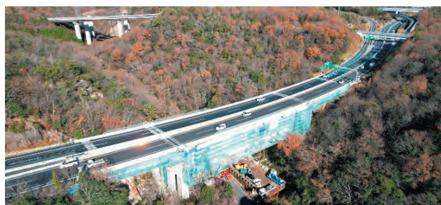
写真-10 床版取替え完了(2023年12月)
