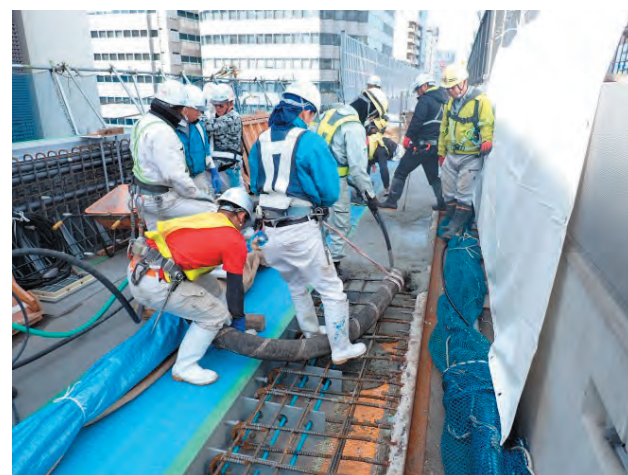
写真-10 二次床版コンクリート打ち込み
