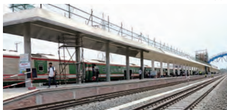
写真-6 プラットフォーム建設
