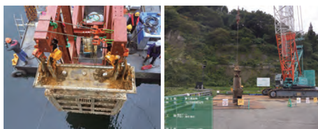
写真-6 撤去・搬出状況
