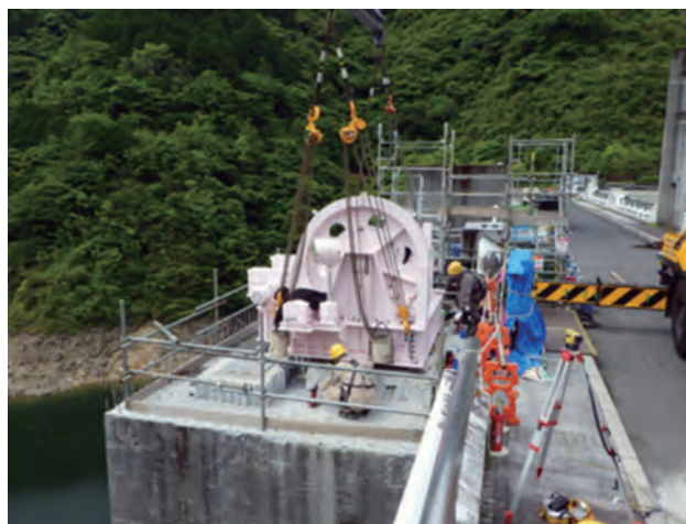
写真-10 開閉装置吊込(下段ゲート)
