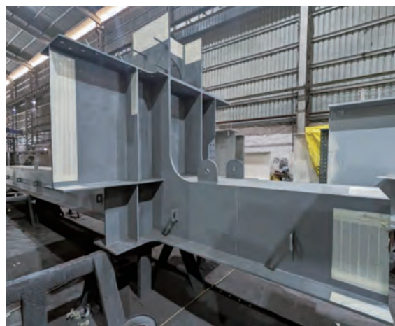
写真-3 鋼トラスブロック塗装状況
