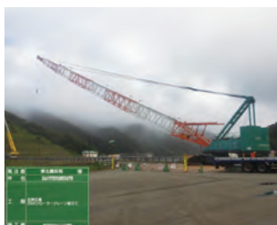
写真-4 台船搬入状況
