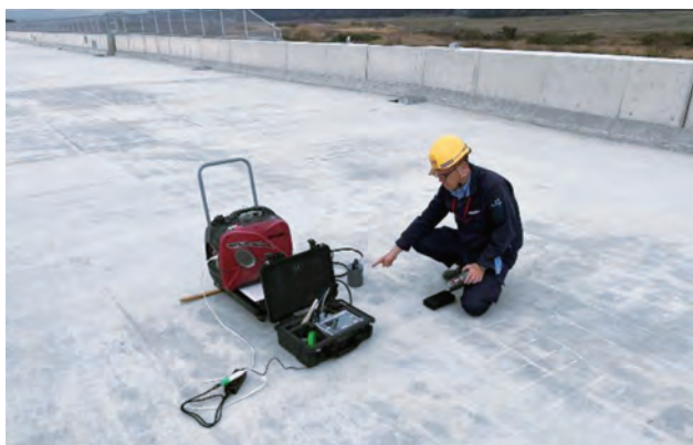
写真-7 透気試験状況
