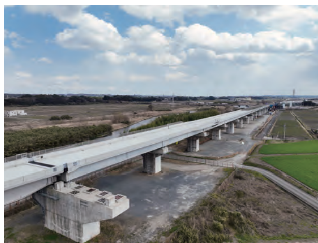
写真-10 完成写真(終点側より)
