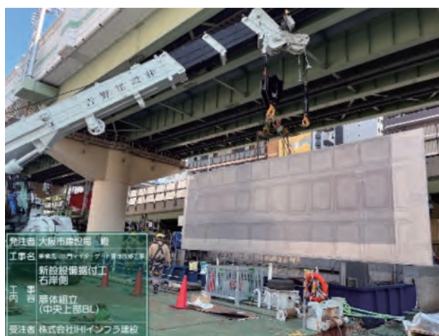
写真-15 右岸側 扉体ブロック吊込
