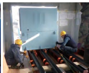
写真-9 レール設置状況
