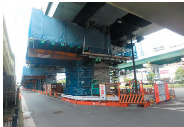
写真-2 RC橋脚拡幅時支保工
