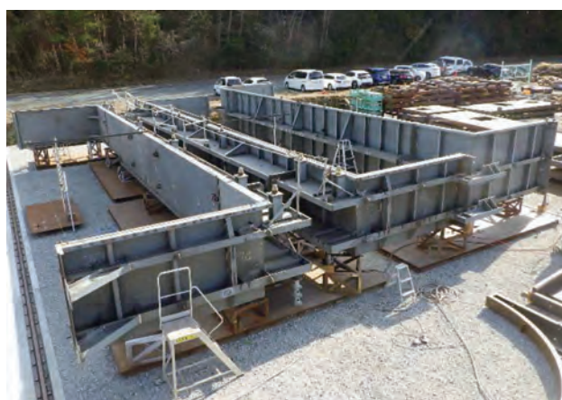
写真-5 仮締切設備仮組立全景
