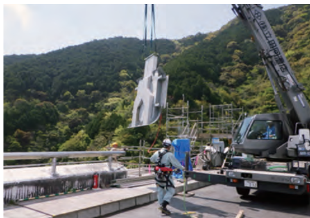
写真-9 上部戸当り吊込(上段・下段ゲート)
