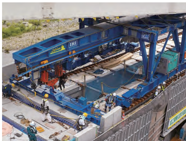
写真-3 スフィンクスの床版取替状況
