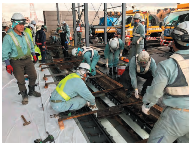
写真-5 伸縮装置据付け
