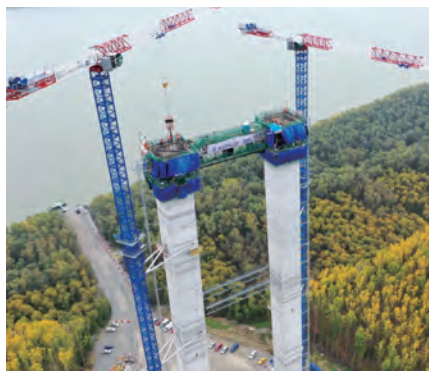
写真-3 スリップフォーム工法による主塔建設
