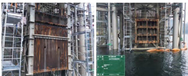
写真-1 改修工事前 制水ゲート扉体(左)、緊急放流ゲート扉体(右)
