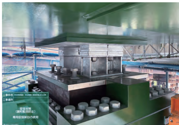
写真-3 溶接上げ越し用仮受け架台
