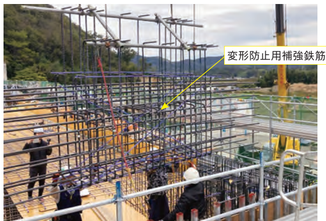
写真-1 プレファブ鉄筋の落とし込み状況
