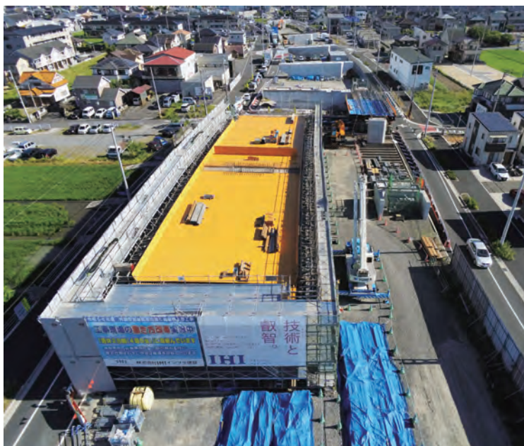
⑧ 南吉田第5高架橋
