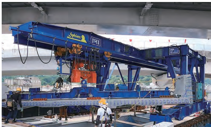
新設床版架設作業
