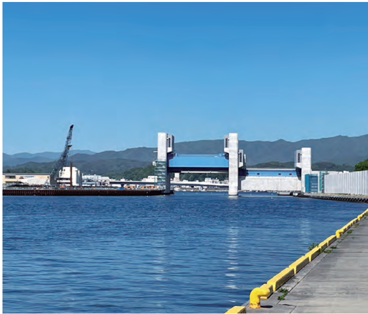
① 関伊川水門
