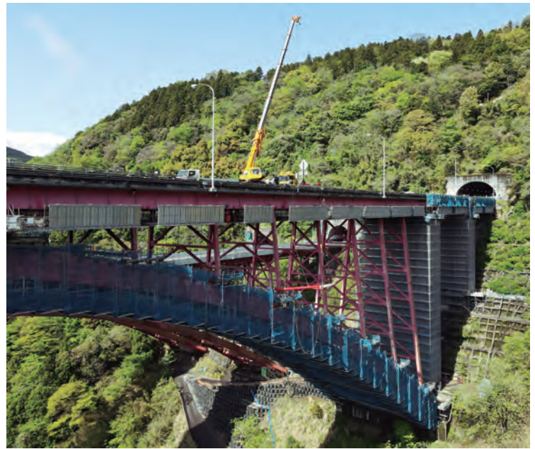
① 皆瀬川橋 座屈拘束ブレース設置
