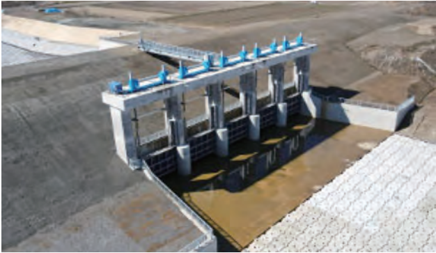
写真-1 設備全景 (雄物川本川側から見る)
