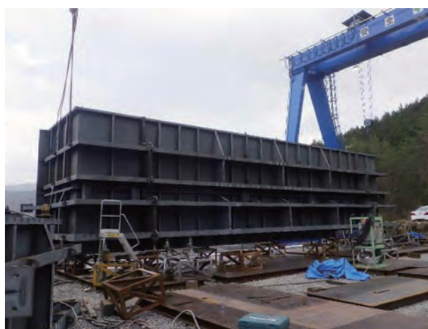
写真-6 上下段搭載状況
