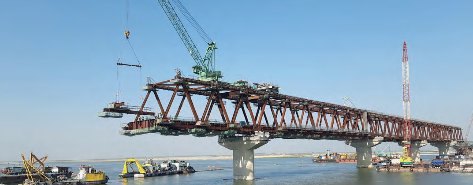
写真-1 トラベラークレーン架設状況
