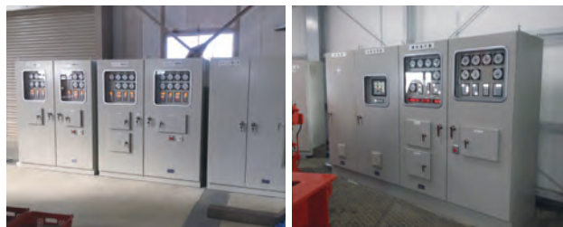
写真-16 施工完了
