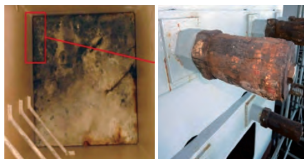
(c) 主塔内面 (d) アンカーボルト
