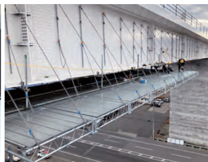
高架橋架設工事での施工例
