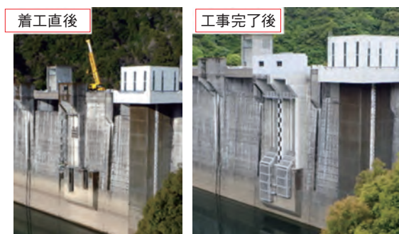
写真-1 設備外観(着工直後および工事完了後)
