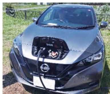
写真-6 EVからの受電状況
