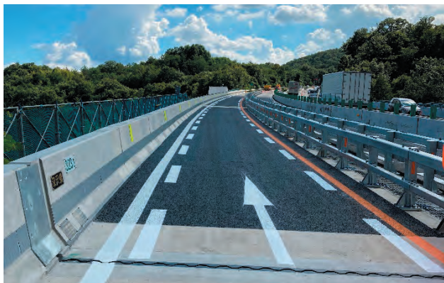
写真-7 走行車線側床版取替(一時開放準備)完了
