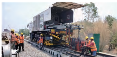
写真-5 レール フラッシュバット溶接
