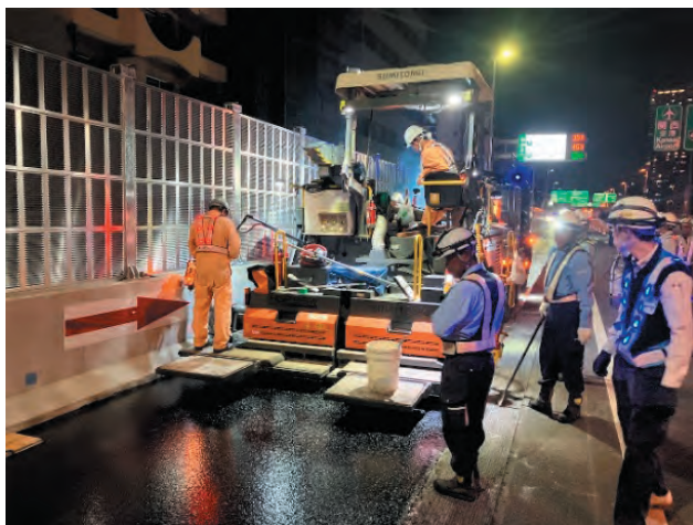
写真-11 基層グースAs舗設
