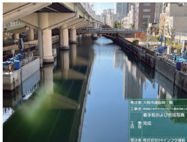
写真-17 完成(下流より見る)
