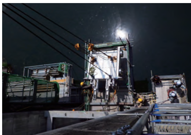
写真-7 新設扉体吊込(下段ゲート)
