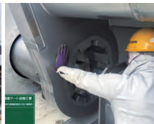
写真-7 トルク軸挿入状況
