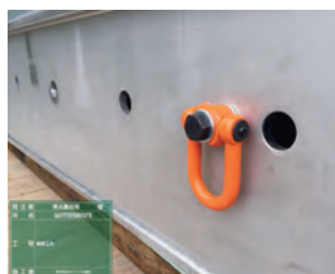
写真-7 マルチアイボルト取付状況
