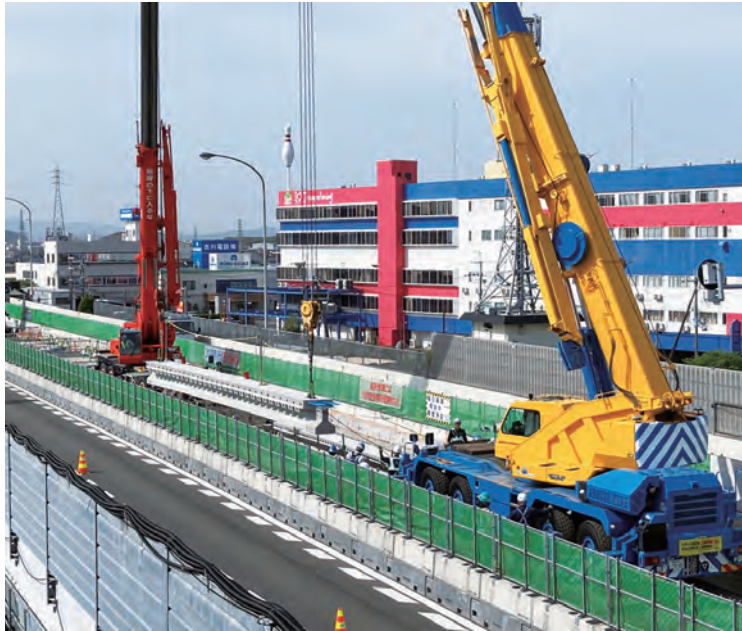
⑦ 松島高架橋他9橋橋梁更新工事
