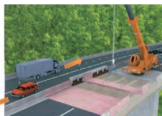
図-1 床版取替工事のイメージ
