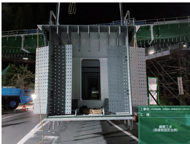
写真-5 添接板 観音開き状況
