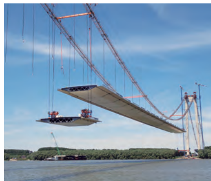
写真-4 ストランドジャッキによる桁架設
