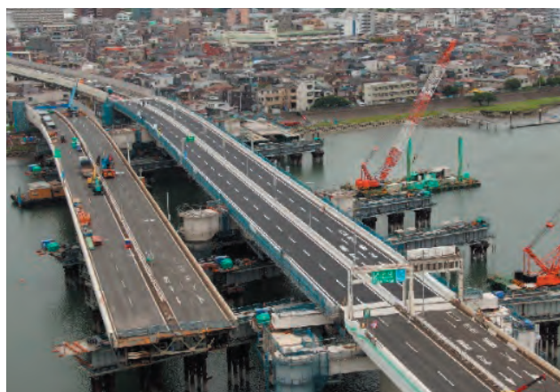
写真-3 新設橋横取り後（提供：首都高速道路株）
