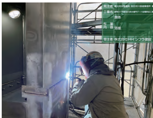
写真-6 扉体端部桁の溶接状況
