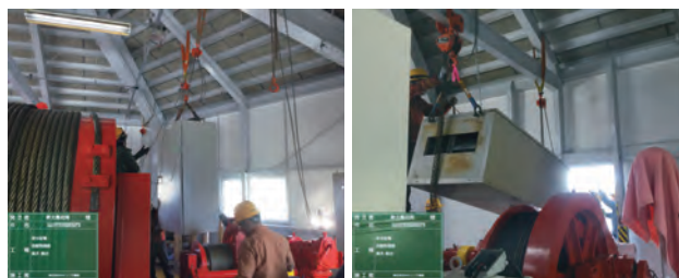
写真-15 撤去状況
