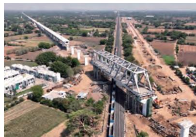
現地架設現場
