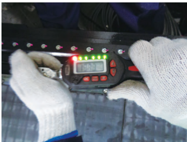
写真-5 固定子締結ボルトのトルク締め
