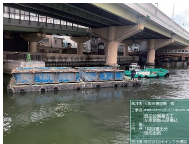
写真-13 撤去品搬出・現地出航
