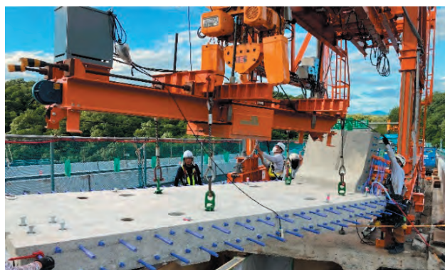
写真-6 P1-P2床版取替状況
