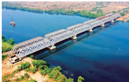
15A工区完成全景
