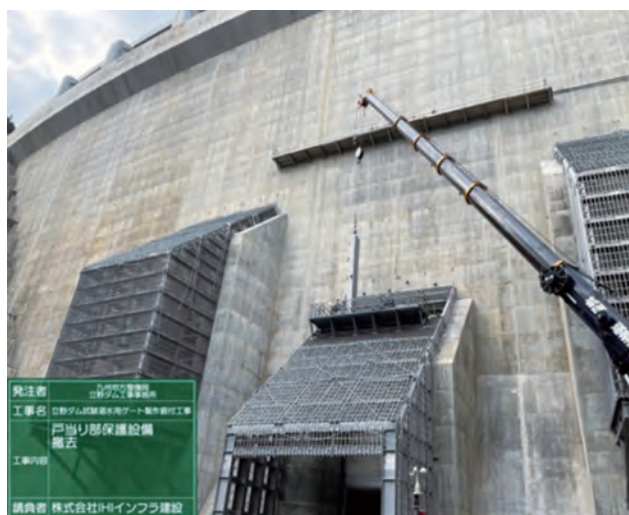
写真-3 試験湛水前撤去状況
