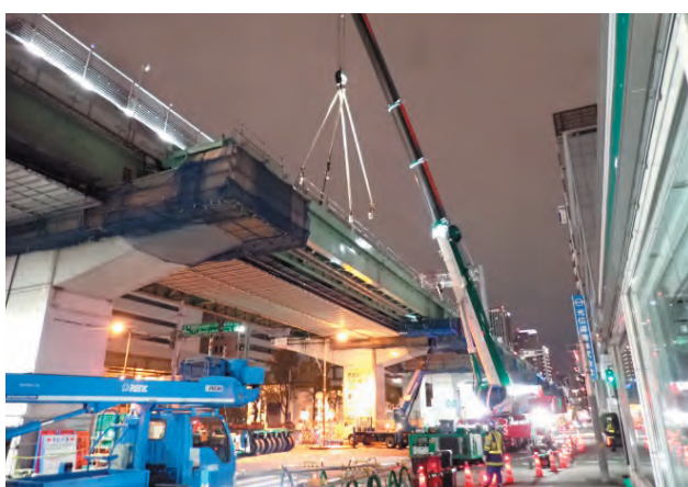
写真-8 220t吊A/Cによる架設
