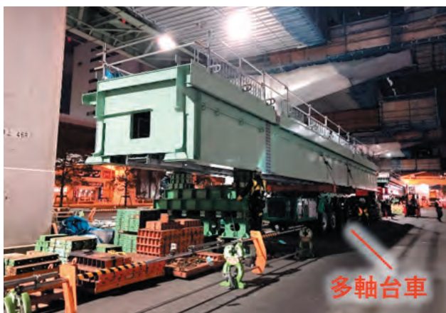
写真-9 多軸台車による架設桁の運搬
