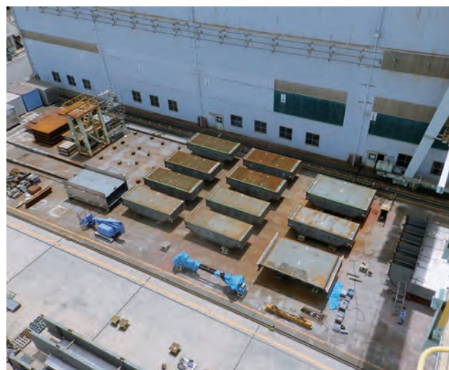
写真-1 扉体仮組立検査全景
