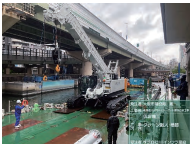
写真-8 クレーン搬入・積替(75tTCC)
