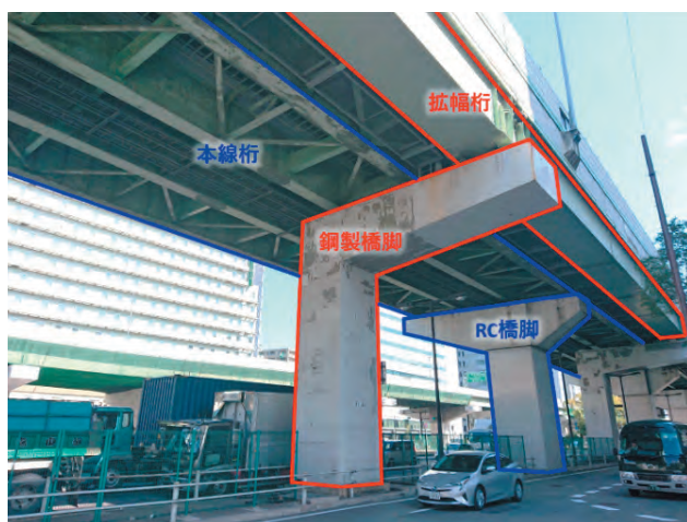
写真-1 施工前 現地状況
