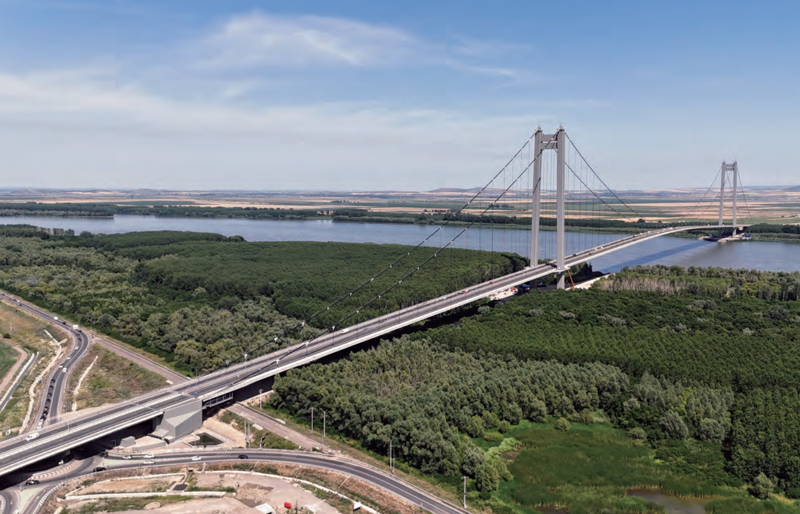
写真-1 ブライラ橋全景
