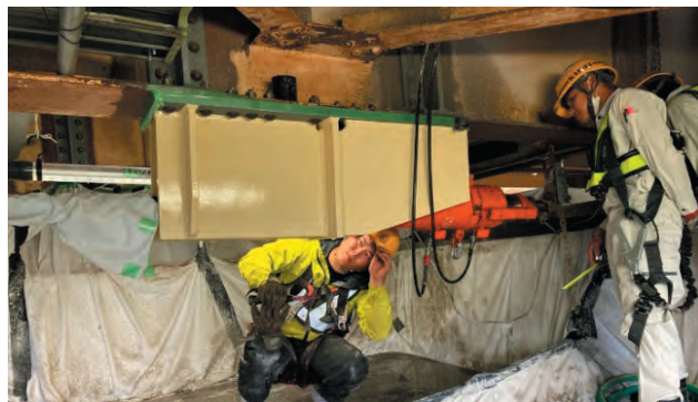
写真-4 外ケーブル緊張状況
