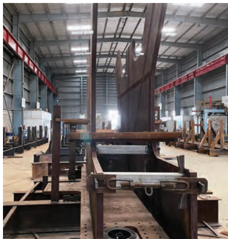
写真-2 鋼トラスブロック製作状況
