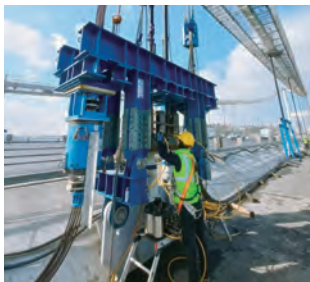
ハンガーケーブル交換作業
