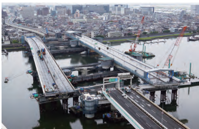
写真-3 既設橋横取り後
