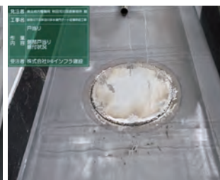
写真-5 打設完了
