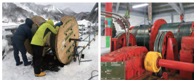
写真-14 新規ワイヤロープ引き込み状況
