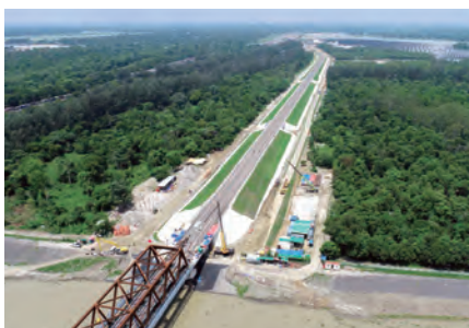
写真-3 盛土区間
