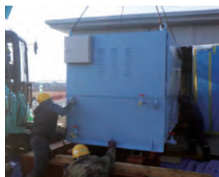
写真-8 油圧ユニット搬入状況
