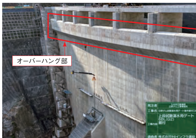
写真-5 吊り込み状況
