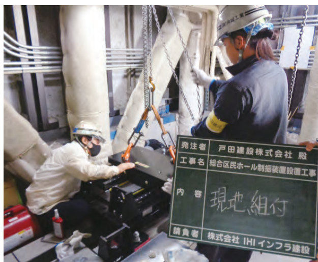
写真-3 現地組み立て作業
