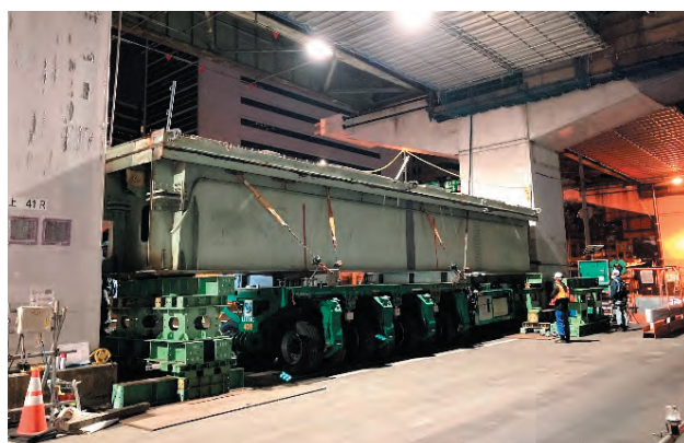
写真-7 多軸台車による仮置き
