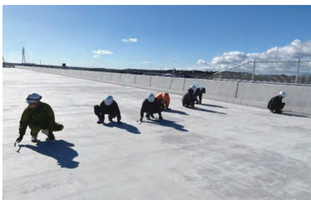
写真-6 ひび割れ調査状況
