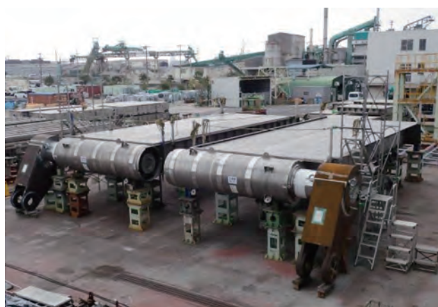
写真-4 扉体仮組立全景
