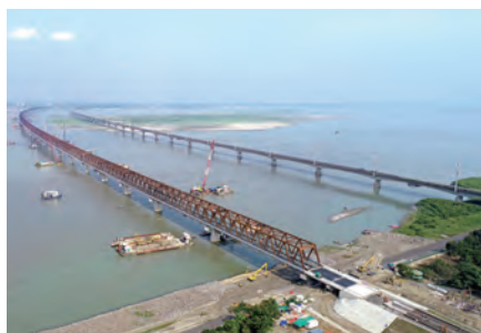
写真-2 橋梁区間
