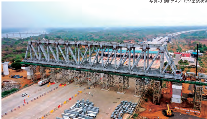
写真-4 GAD1967現地架設状況(架設は当該工事所掌外)
