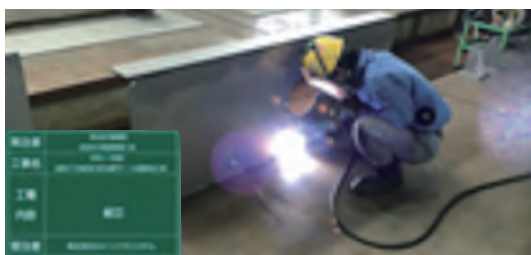
写真-2 工場溶接
