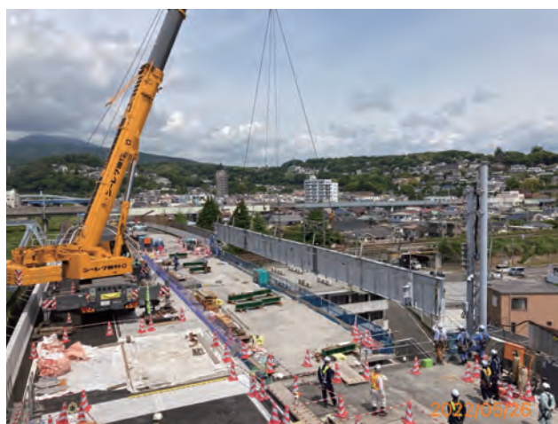
写真-6 新主桁架設状況
