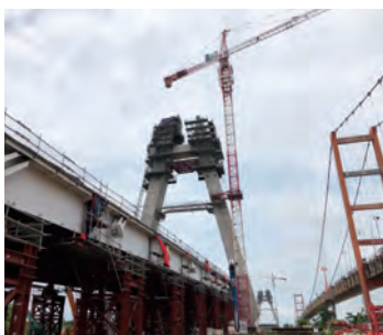
Atrani橋主塔 建設工事とPC上部工と鋼桁地組
