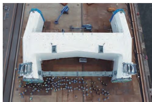
写真-1 中段ブロックの地組完成状況
