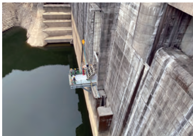
写真-6 既設扉体撤去(下段ゲート)
