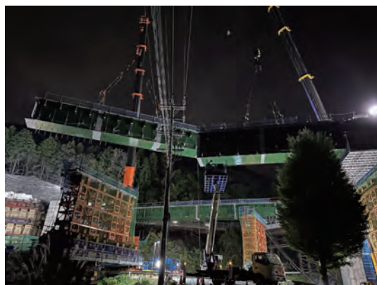
写真-4 大型クレーンリレー 架設
