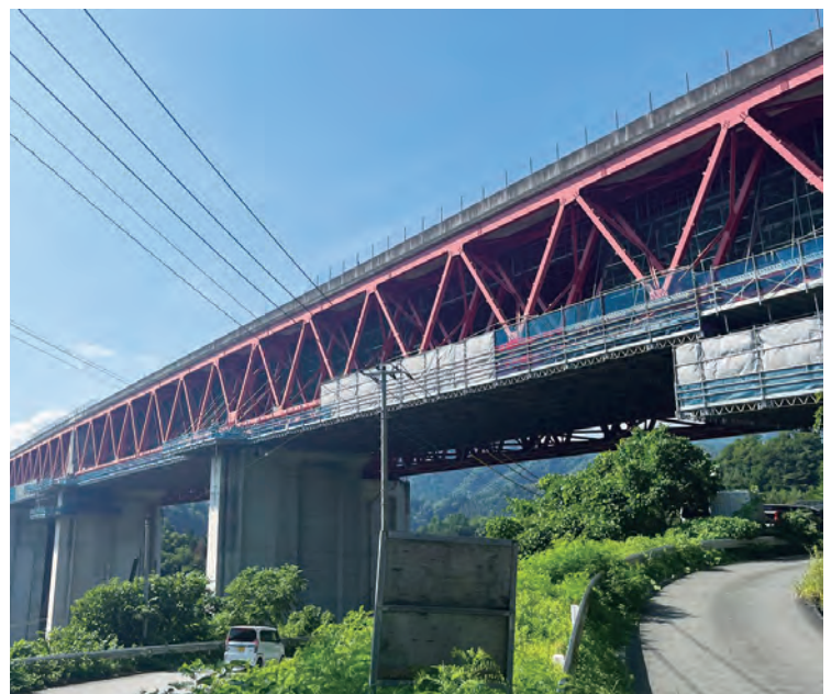
① 鶴川大橋耐震補強工事
