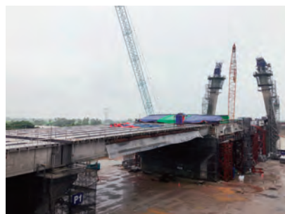
Atrani橋主塔 建設工事とPC上部工と鋼桁地組
