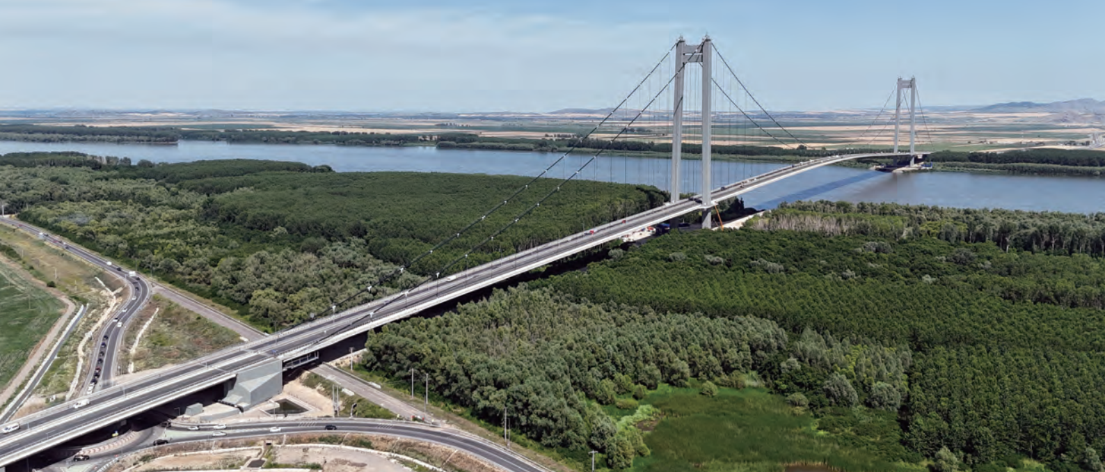
写真-1 ブライラ橋全景
