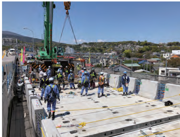
写真-2 早川Bランプ橋PCaPC床版架設状況
