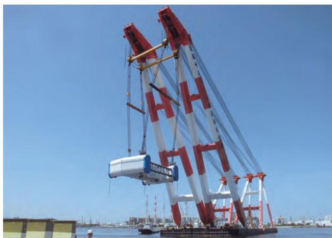
写真-2 中段ブロックの浜出し
