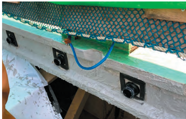
写真-9 PCaPC床版接合部(走行車線側)
