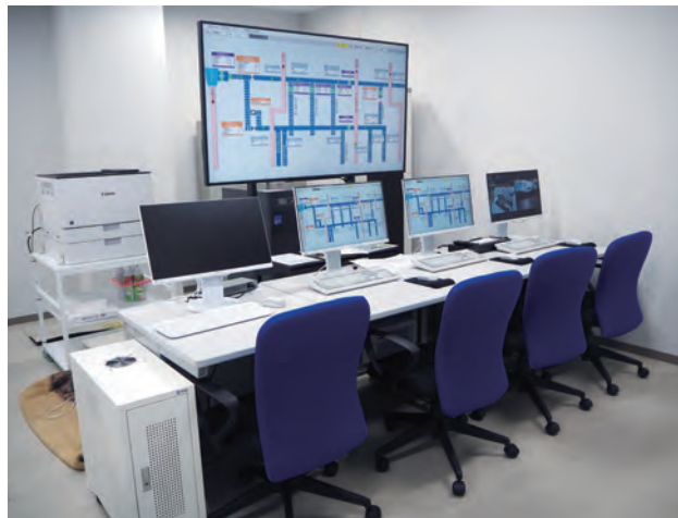
写真-2 完成写真(中央管理所)
