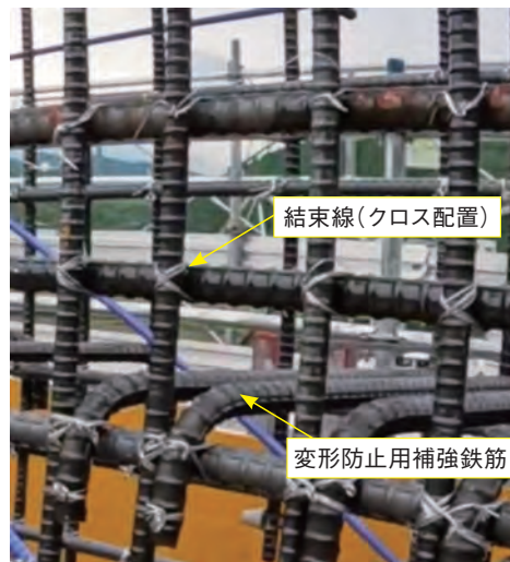
写真-2 結束線のクロス配置
