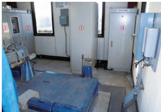
写真-2 据付工事完成(操作室内)
