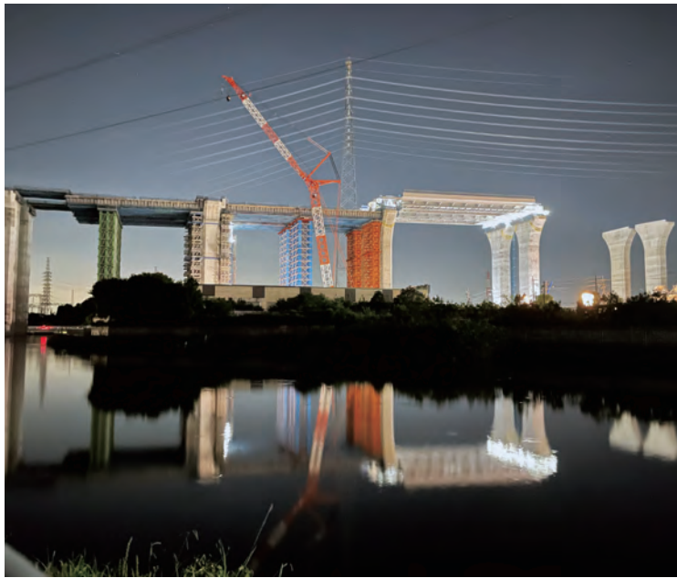
⑳ 高槻高架橋 桁降下完了
