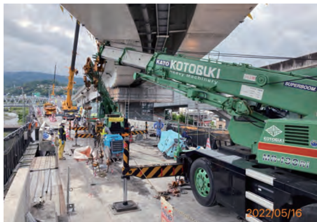
写真-4 既設床版撤去状況
