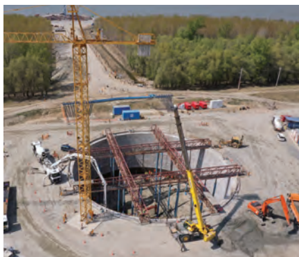
写真-2 アンカレッジ掘削
