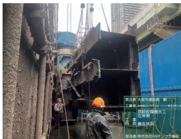
写真-12 左岸側 既設扉体撤去
