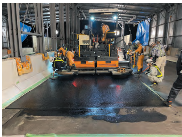
写真-4 上屋内での舗装作業
