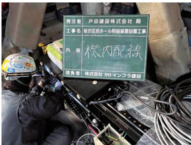
写真-6 制振装置の機内配線作業
