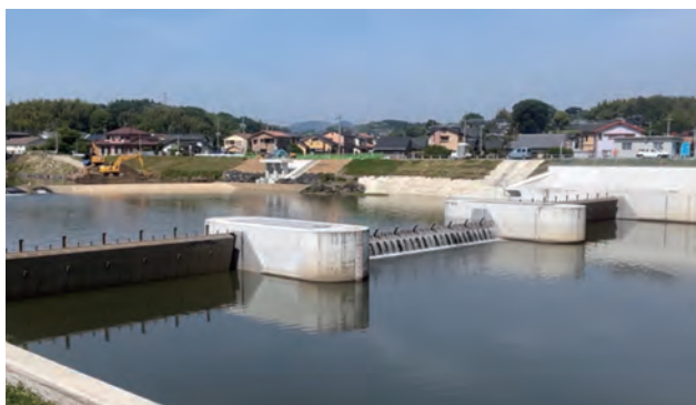
写真-1 全景(下流側)
