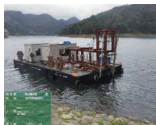
写真-5 台船組立完了
