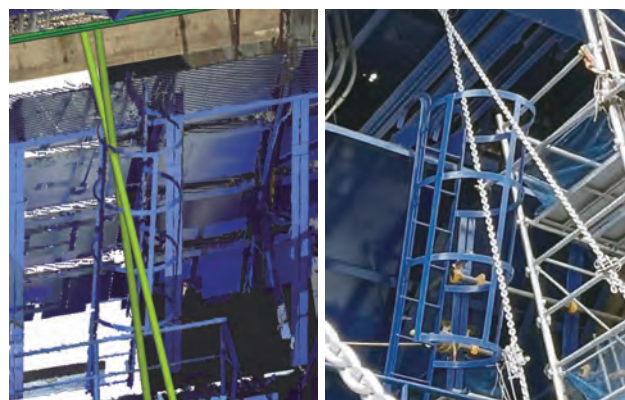
図-4 3次元モデルによる干渉恐れ箇所と仮設後写真
