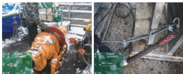
写真-13 既設ワイヤロープ撤去状況
