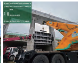
写真-8 扉体の据付
