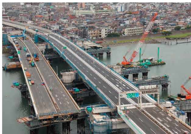
写真-6 通行止め工事完了 (提供: 首都高速道路(株))
