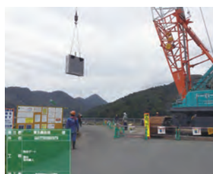
写真-9 扉体搬入状況
