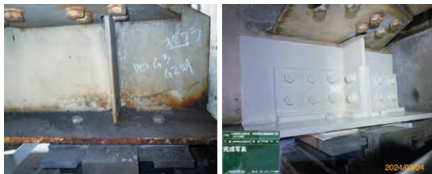
写真-2 鋼桁補修工の施工前・施工後
