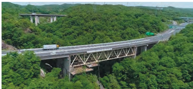
写真-1 深沢橋全景(右手が土岐JCT)
