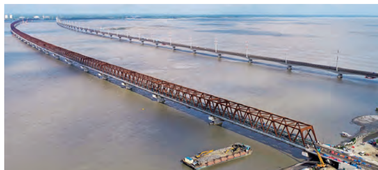
上部工の建設
