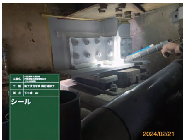
写真-4 止水処理状況
