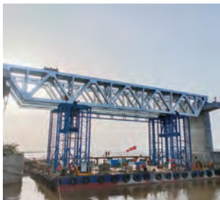
15B工区台船架設
