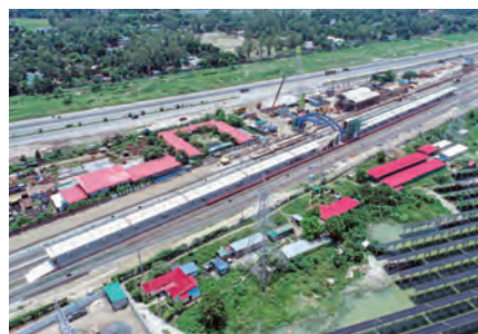
写真-4 改築区間
