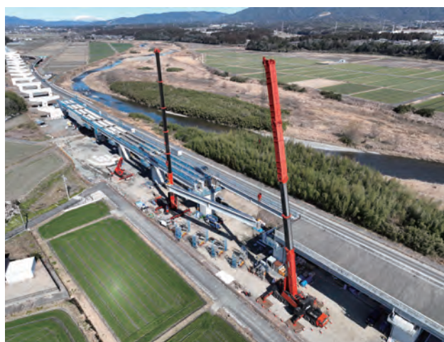
写真-9 主桁架設状況
