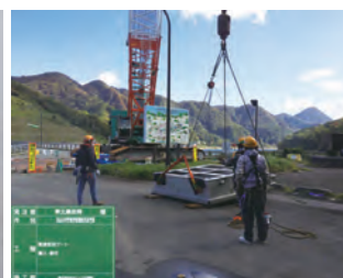
写真-8 扉体引き起こし状況
