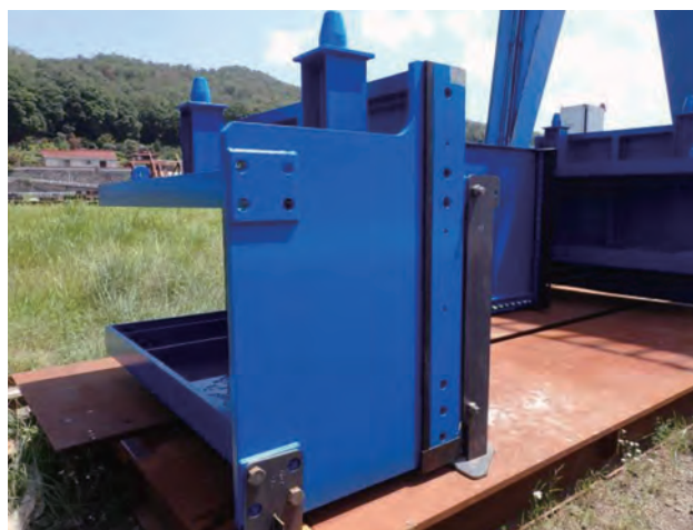
写真-7 水密ゴム取付状況
