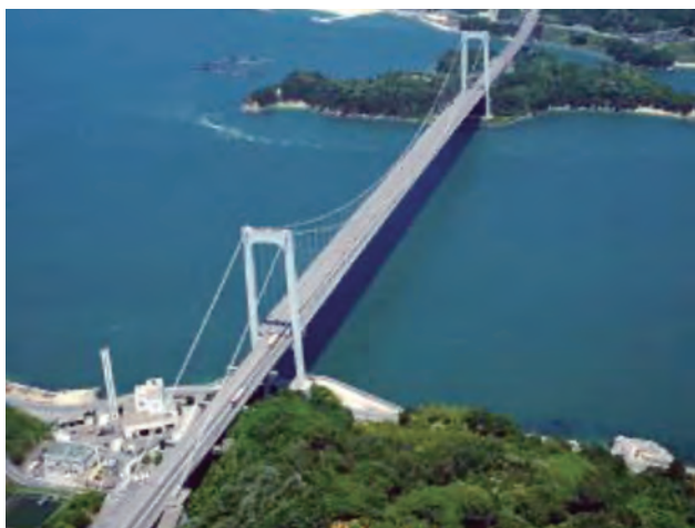
写真-1 大島大橋
