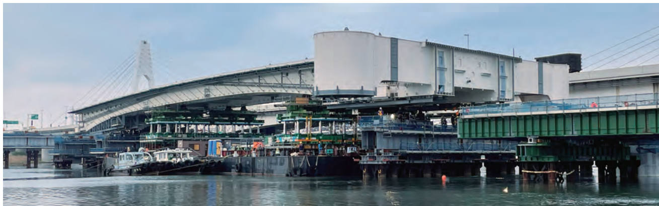
写真-4 台車リフトアップ架設
