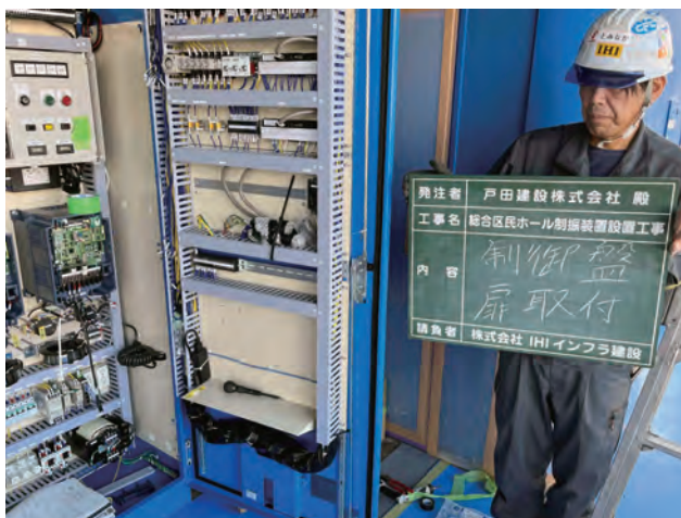
写真-7 制御盤再組み立て
