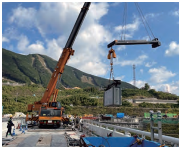
写真-4 吊り込み状況
