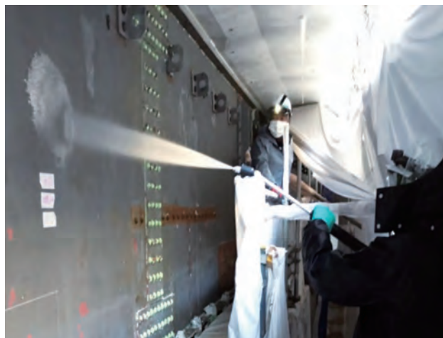
写真-7 水洗い状況
