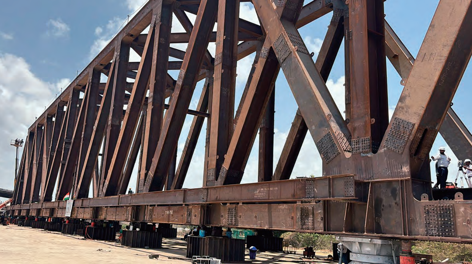
写真-1 GAD15仮組立状況(130m+100m連続スパンの100m側)
