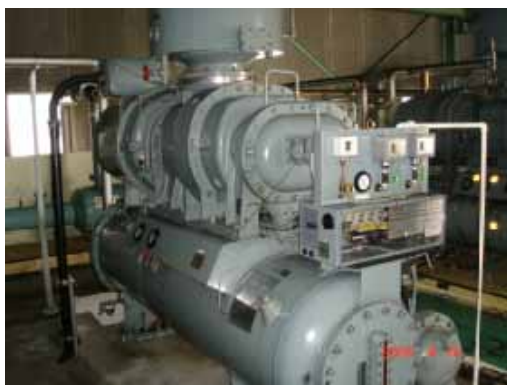
コンプレッサーの省電力化改造
