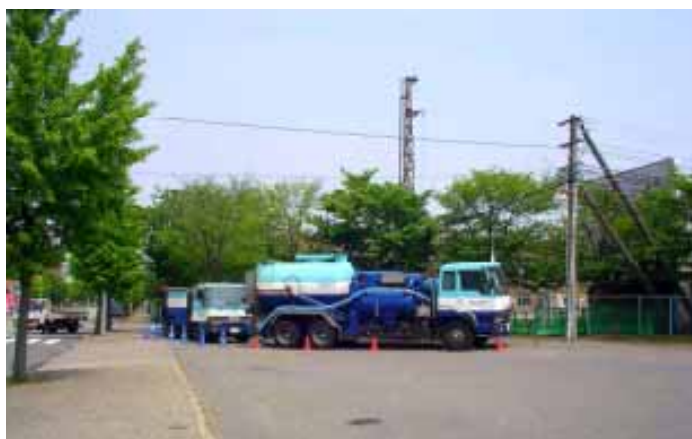
新潟内燃機工場：工場周辺のバスターミル排水溝清掃
