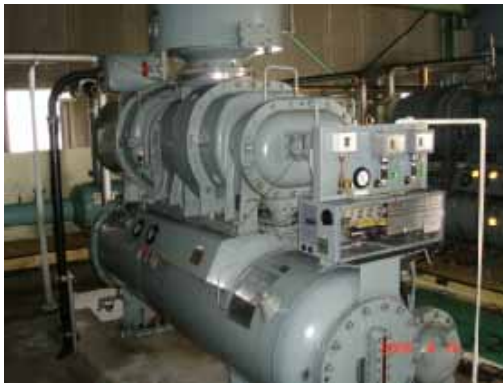
コンプレッサーの省電力化改造
