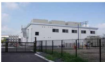
（株）フェスコパワーステーション群馬 N P S 太田発電所(2006 年 22AG 納入)
