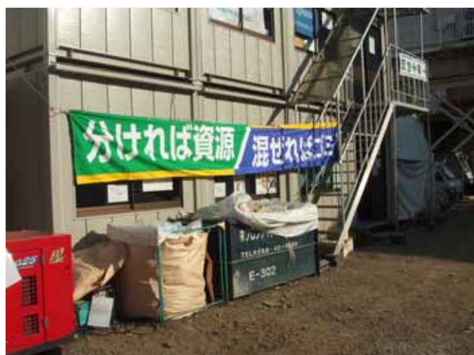
工事現場での廃棄物・資源の分別
