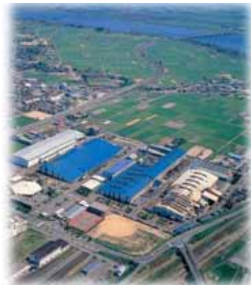
新潟内燃機・鑄造工場 (新潟県)
