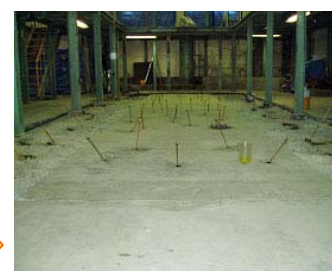
要所要所に補強筋の埋設
