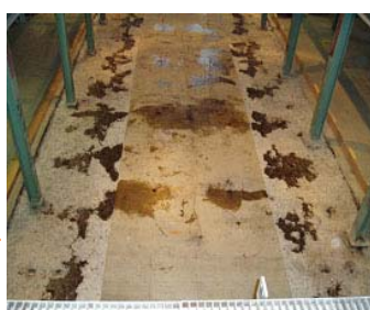
全箇所のエポキシ注入完了
