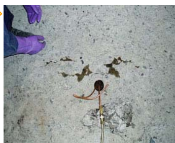
補強筋を挿入した箇所に、エポキシ 注入口より注入（近傍の亀裂箇所よ りエポキシがにじみ出る）
