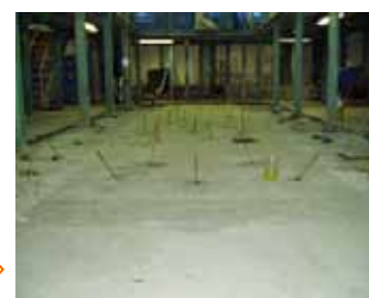
要所要所に補強筋の埋設
