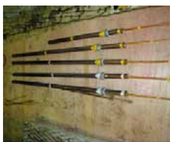
補強筋埋設とエポキシ樹脂を注入し、 基礎の一体化を図れば十分使用可能 な基礎と判断された
