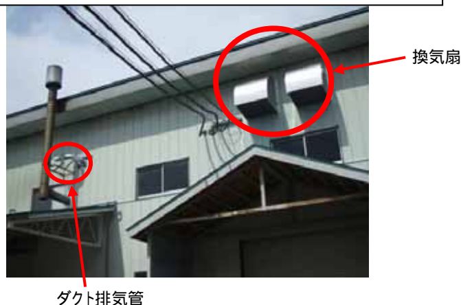
対策後 熱処理工場換気扇新設及び排気口移設写真
