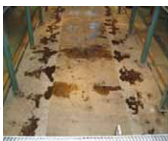
全箇所のエポキシ注入完了
