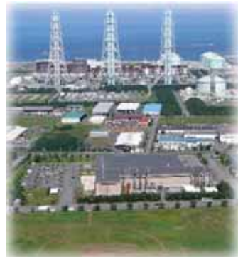
ガスタービン工場 (新潟県)
