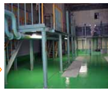
コンクリートにて表面仕上げ完了 床部分に塗り床仕上げを行い、 新しい発電装置の搬入を待つ
