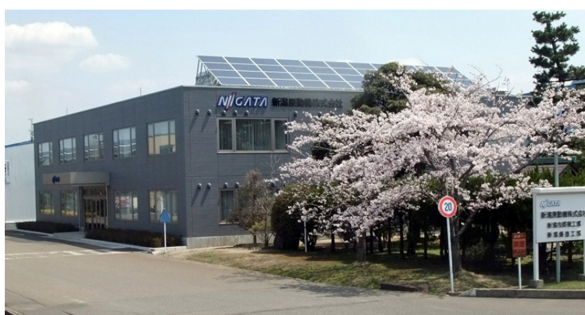
新潟内燃機工場の新事務所棟 (屋根にソーラーパネルを設置)
