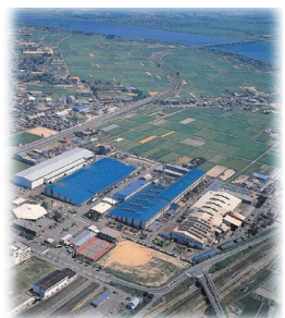
新潟内燃機・鋳造工場 (新潟県)
