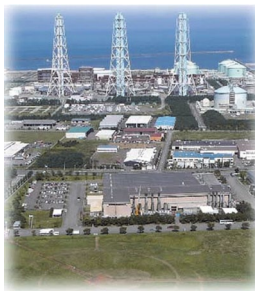
新潟ガスタービン工場 (新潟県)
