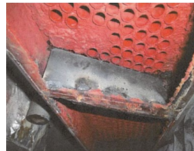
No.15 作業中（背面） 水室ケース溶断開放後 （仕切り板穴あき部補修 後）
