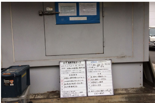
メンテナンス工事の様子
