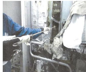
No.9 作業中（前面） 水室ケース溶断開放後 （チューブブラッシング 清掃中）
