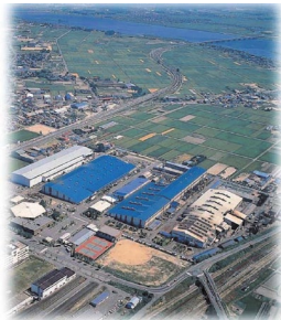
新潟内燃機・鋳造工場 (新潟県)
