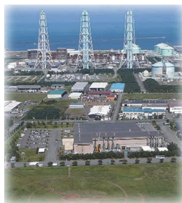
新潟ガスタービン工場 (新潟県)
