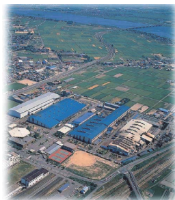
新潟内燃機・鋳造工場 (新潟県)
