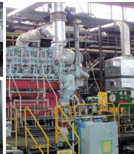
新潟内燃機工場
