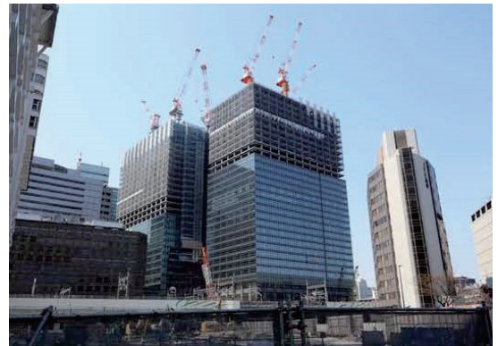
建設途中の現場写真
