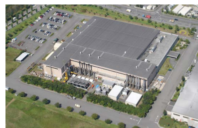
新潟ガスタービン工場(新潟県)
