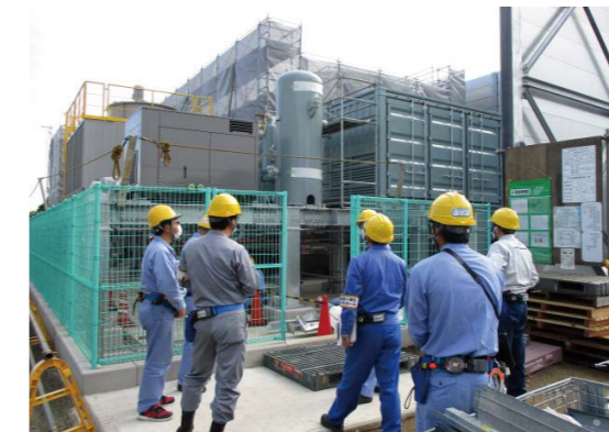
2020年10月22日 安全パトロール (IHI横浜事業所 ガスエンジンCGS 注 発電所 建設工事)
