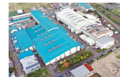
新潟内燃機・鑄造工場 (新潟県)
