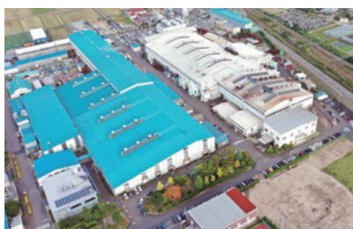
新潟内燃機・鑄造工場（新潟県）
