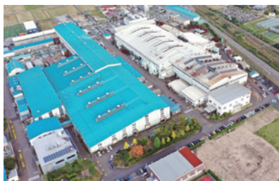
新潟内燃機・鋳造工場 (新潟県)
