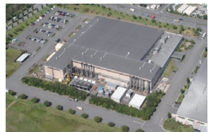
新潟ガスタービン工場 (新潟県)
