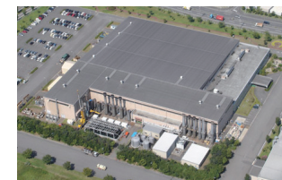
新潟ガスタービン工場 (新潟県)
