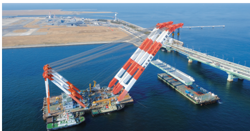
復旧工事の様子
