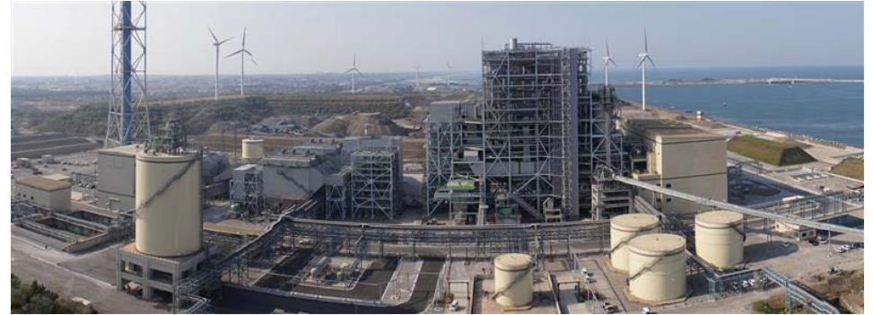
鹿島パワー(株)殿鹿島火力発電所2号機全景
