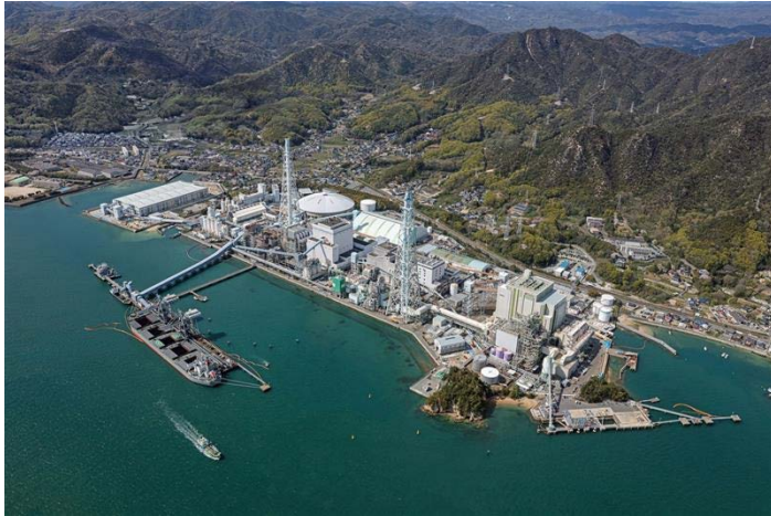
電源開発(株)殿竹原火力発電所新1号機・3号機全景
