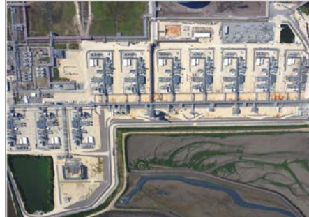
据付完了状況
