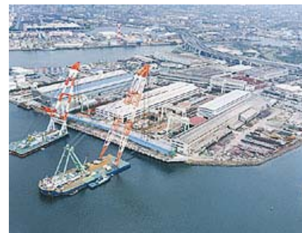
橋梁・水門の主力生産拠点(大阪府堺市)
