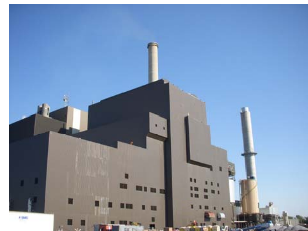
稼動中の大型ボイラプラント
