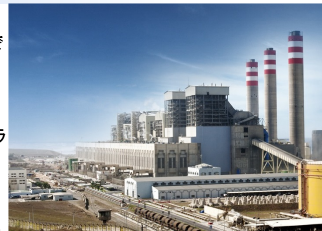
<ジョルフラスファール発電所>
