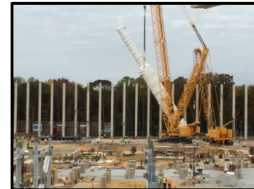
主熱交換器据付
