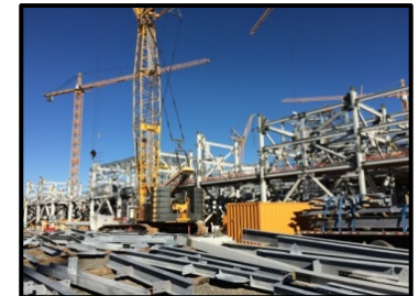
液化エリア配管架設建設
