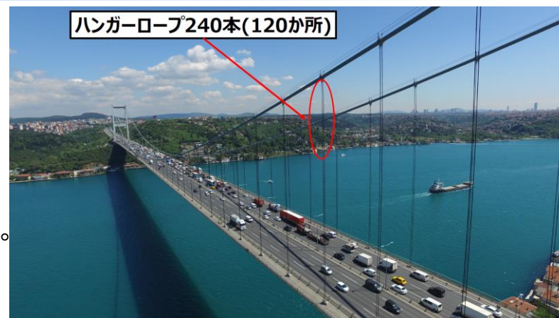
<第2ボスポラス橋>
