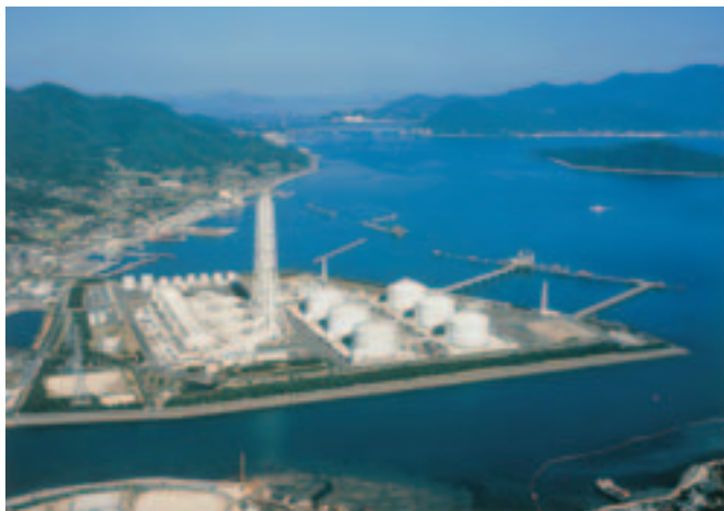
■LNG受入ターミナル
