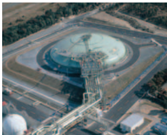
■LNG地下タンク
