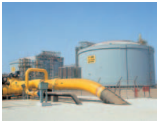
■LNG地上タンク(PC)
