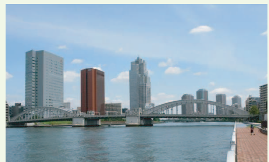
現在の勝鬨橋
