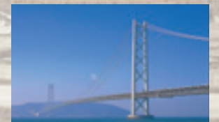
主塔、橋桁の製作、建設に携わった世界最大の吊り橋「明石海峡大橋」完成
