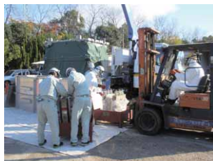
高濃度PCB使用電気機器搬出状況 (IHI愛知事業所)
