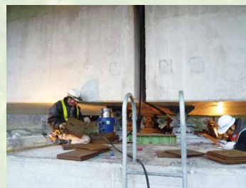
釜戸川橋（福島県）の復旧工事
