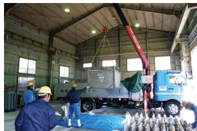
PCB含有機器の搬出
