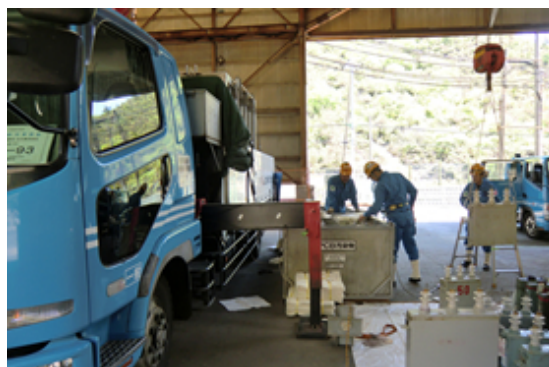
PCB含有機器の搬出
