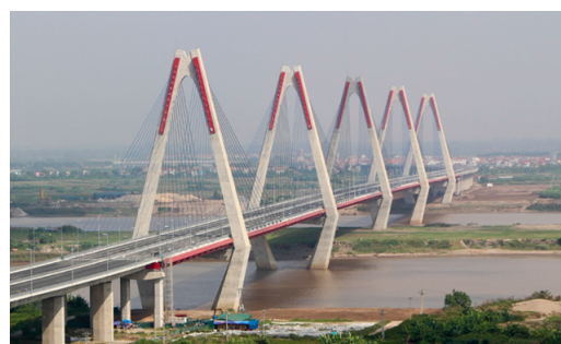
ニャットン橋
