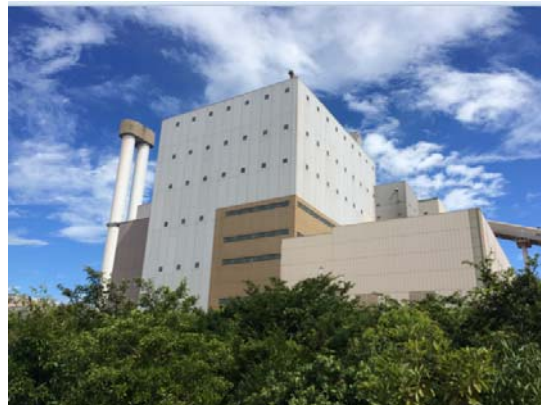
2004年にIHIが納めた神鋼神戸発電所2号機
