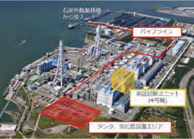
実証事業を行なうJERA碧南火力発電所(愛知県碧南市) 写真提供: JERA
