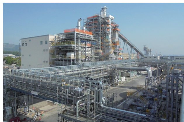
七ツ島バイオマス発電所
