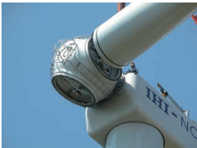
ブレードの取付作業
